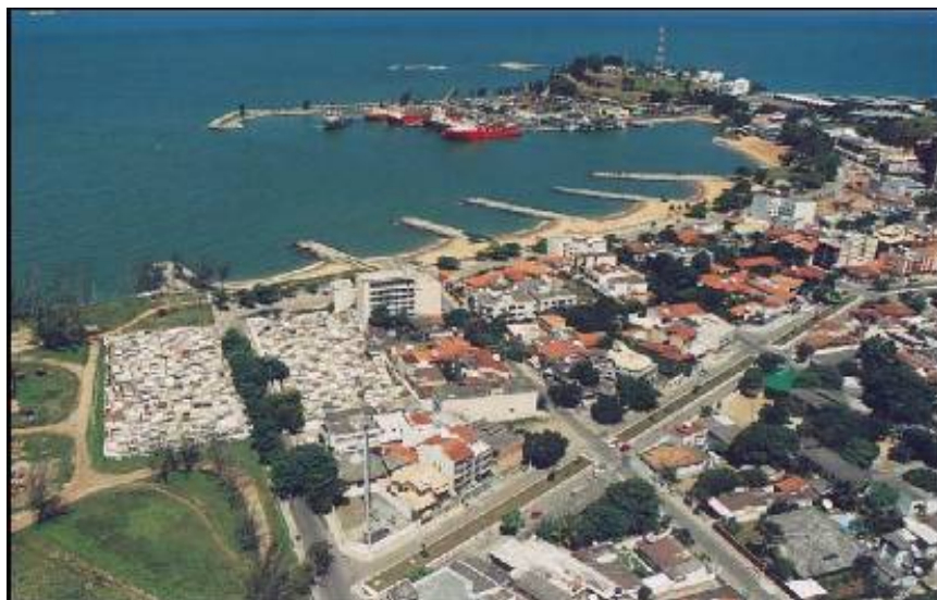
Figura II.5.32-10 - Porto de Imbetiba – Macaé.
