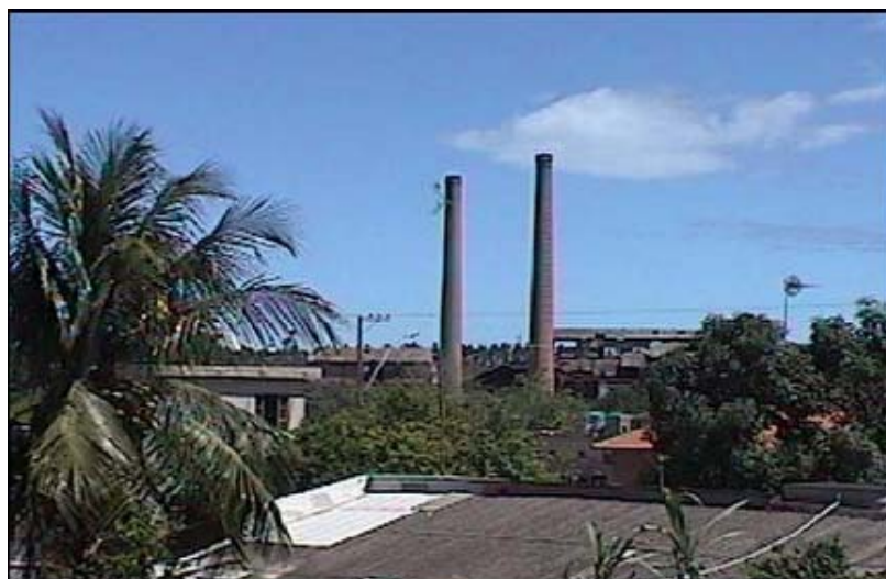
Figura II.5.3-13 - Usina de Carapebus.
