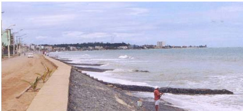
Figura II.5.2-10 - Molhes construídos na Praia de Maratízes/ES.
