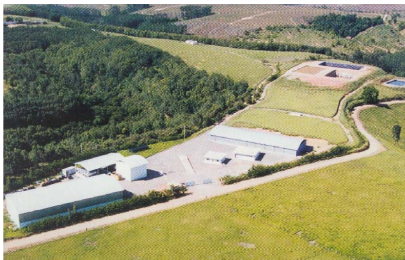
Figura II.2.4-27 - Vista aérea da empresa Vitória Ambiental
