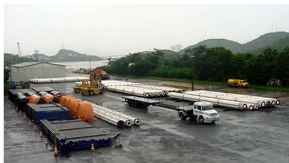
Figura 2.10 Parque de tubos na CPVV.
