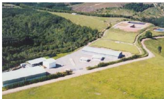
Figura 2.11 - Vista aérea da empresa Vitória Ambiental.
