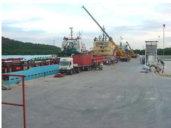
Figura 2.9 Cais para rebocadores do Terminal da CPVV.
