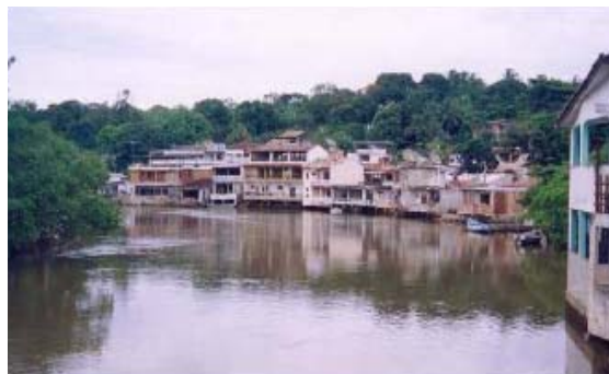
Figura 3.30 Ocupação desordenada nas margens do rio Perocão, Guarapari/ES.
