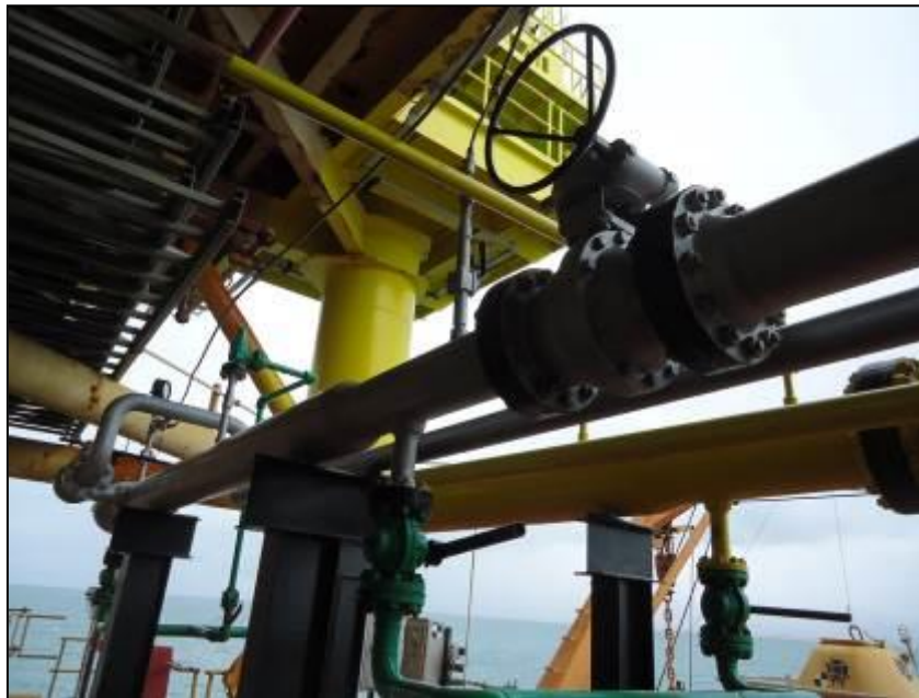
Figura 3 – Lançador de pig do oleoduto de 6”
