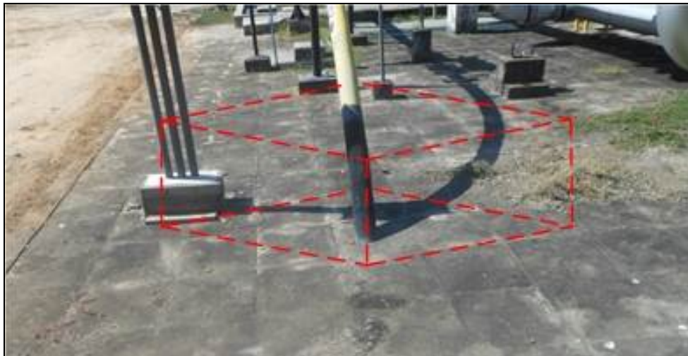
Figura 7 – Local de escavação para seccionamento do gasoduto de 4" na Estação de Fazenda Cedro
