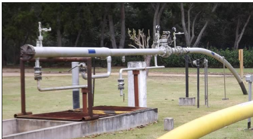
Figura VI.3-2 - Recebedor de pig do oleoduto de 6"
