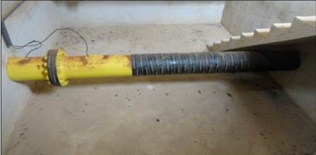
Figura 2 – Trecho aéreo do gasoduto de 10" dentro da caixa de contenção próxima à praia de Urussuquara
