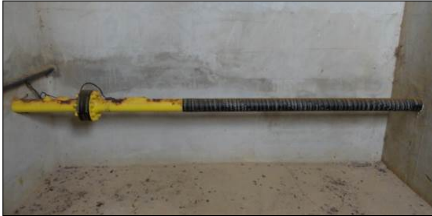
Figura 2 – Trecho aéreo do gasoduto de 4" dentro da caixa de contenção próxima à praia de Urussuquara
