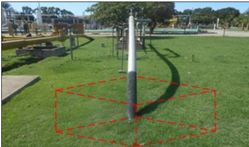
Figura 4 – Local de escavação para seccionamento do oleoduto de 6” na Estação de Fazenda Cedro
