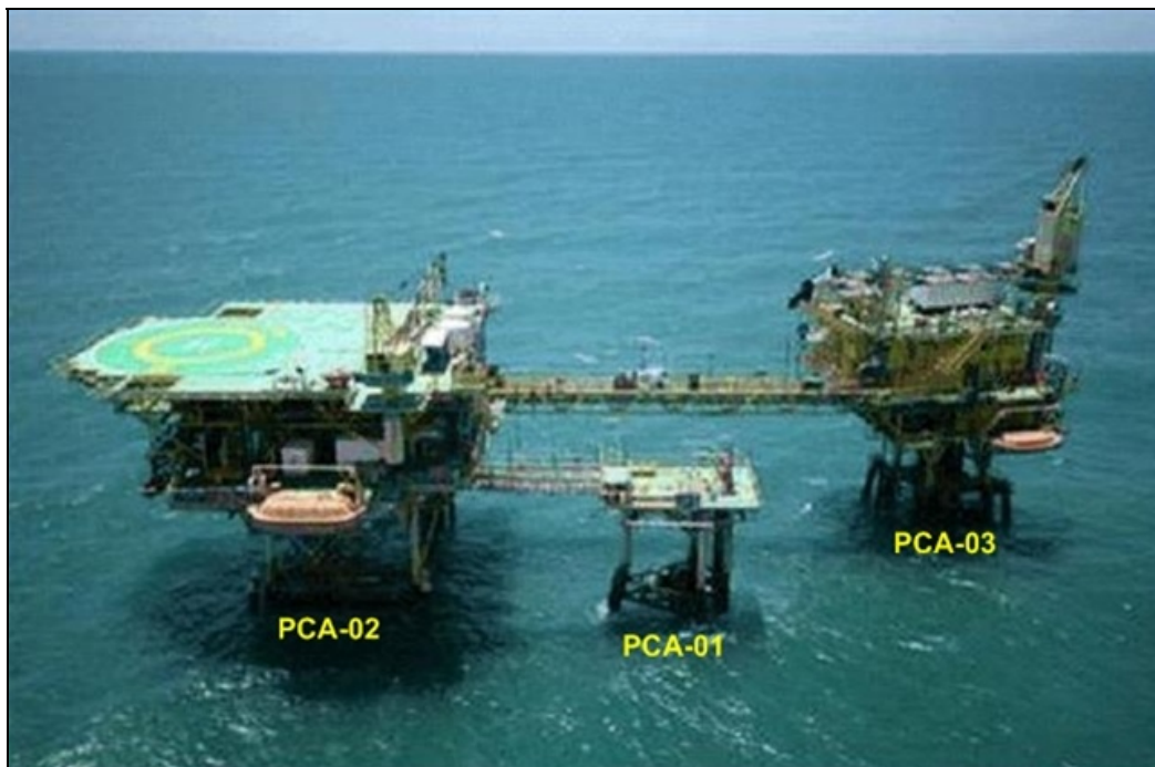
Figura I-1 – Plataforma de Cação
