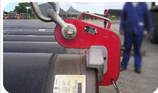
Figura 11 – Instalação da patola no duto
