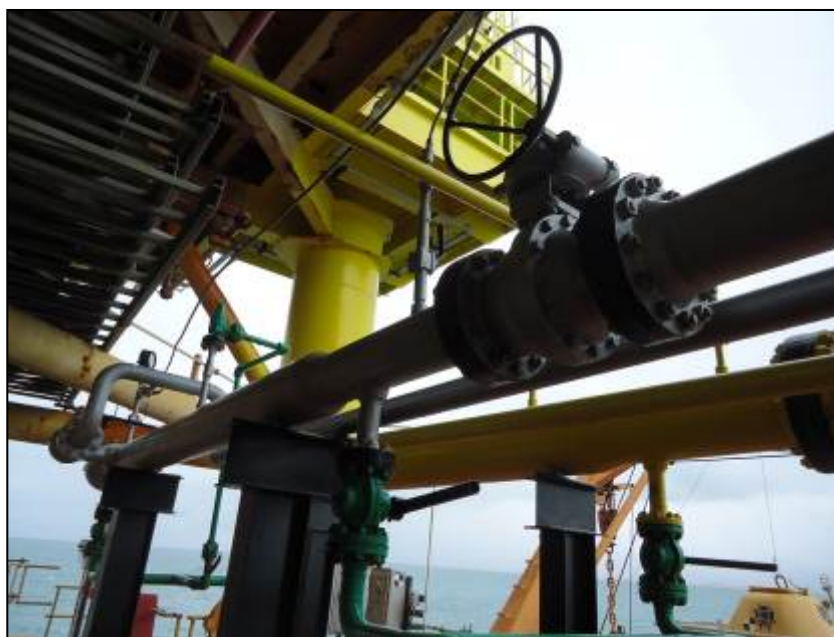
Figura 3 – Lançador de pig do oleoduto de 6"
