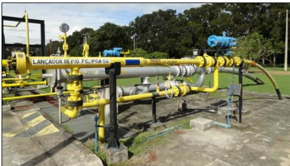
Figura 1 – Lançador de pig do gasoduto de 4"
