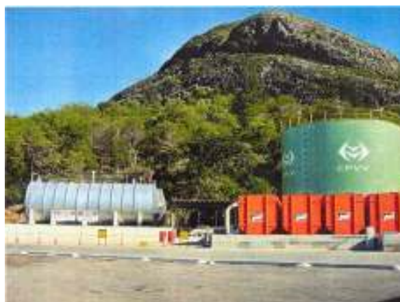
Figura II.2.4-20 - Tancagens de armazenamento no interior da CPVV
