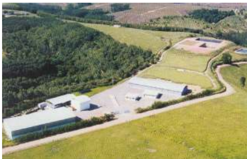
Figura II.2.4-24 - Vista aérea da empresa Vitória Ambiental
