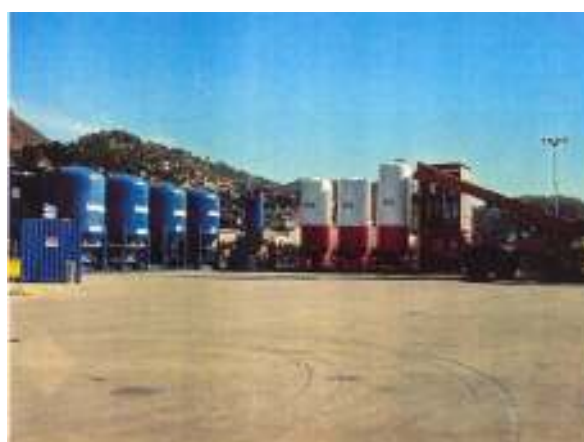
Figura II.2.4-21 - Tancagens de armazenamento no interior da CPVV
