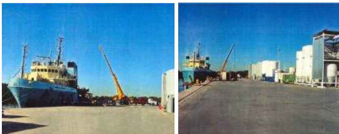
Figuras II.2.4-17 e II.2.4-18 - Píer para rebocadores da CPVV
