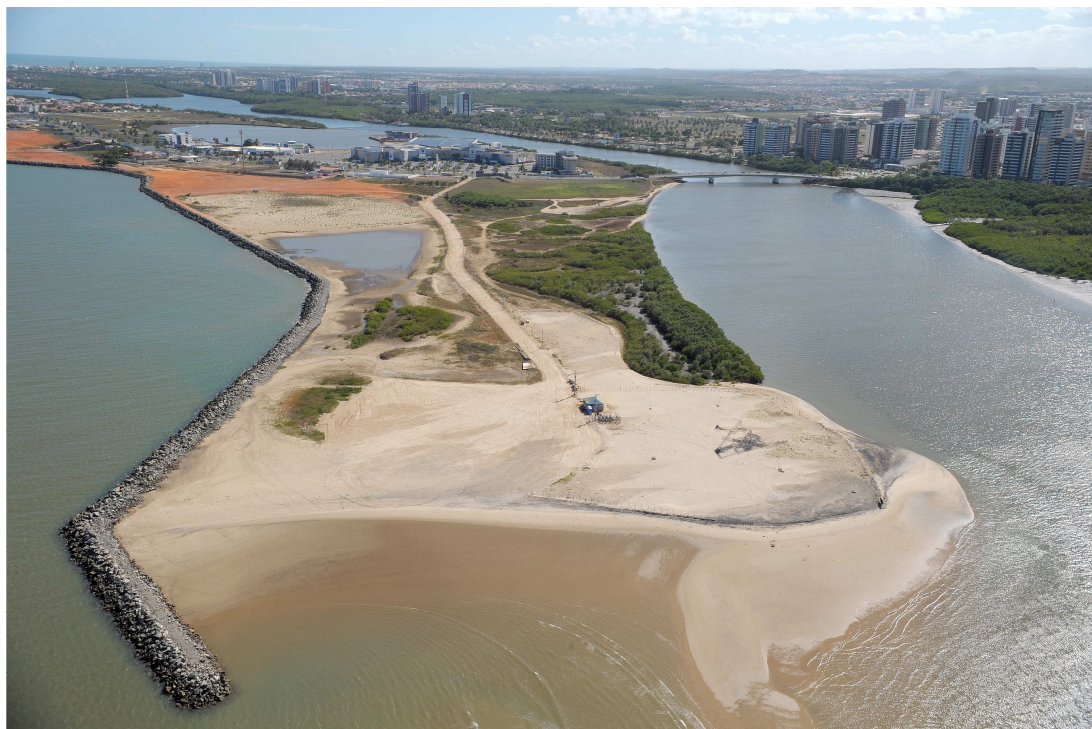
Base do aerobarco imediatamente após a retirada das estruturas e concreto.
