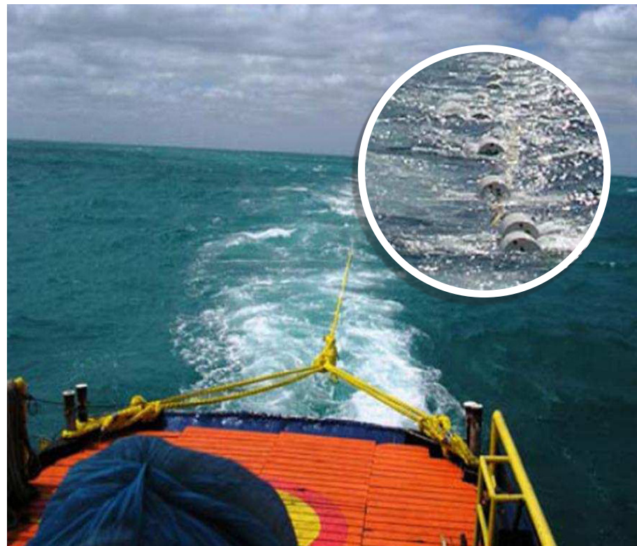
Lançamento de dutos sinalizado por boias (detalhe)
