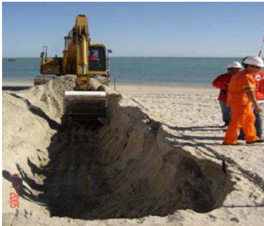
Abertura de vala na praia para passagem de novos dutos
