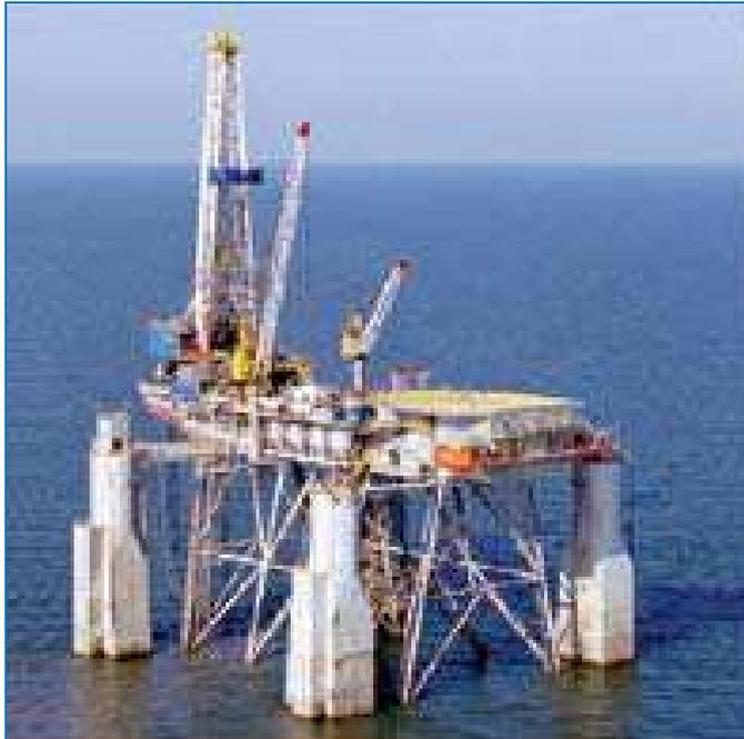
**Figura II.3-2** - Ilustração de uma plataforma submersível.
