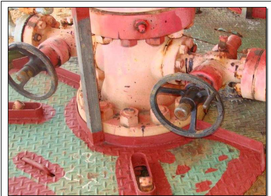
Instalação de tricanizes no entorno das árvores de natal secas (ANS).
