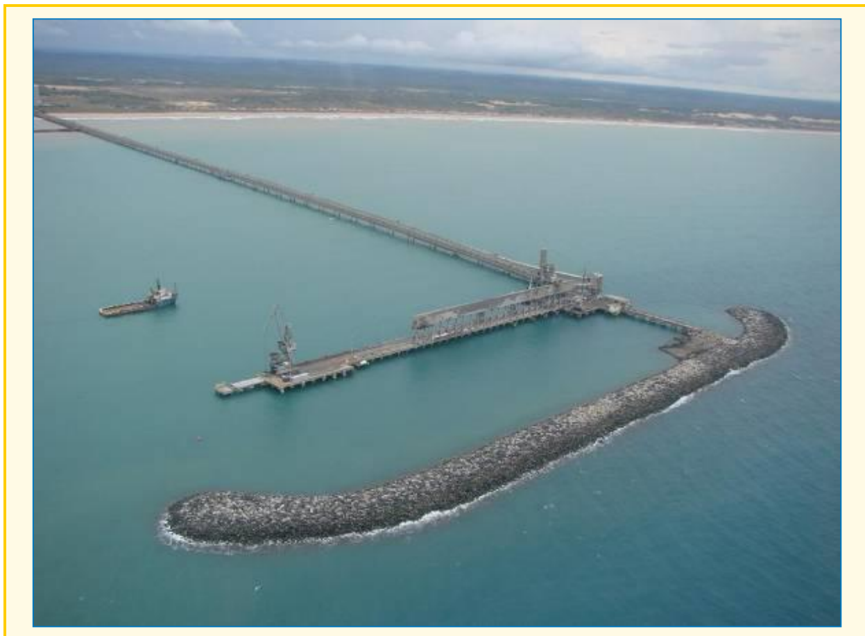
Figura 7 – Vista área do Terminal Marítimo Inácio Barbosa
