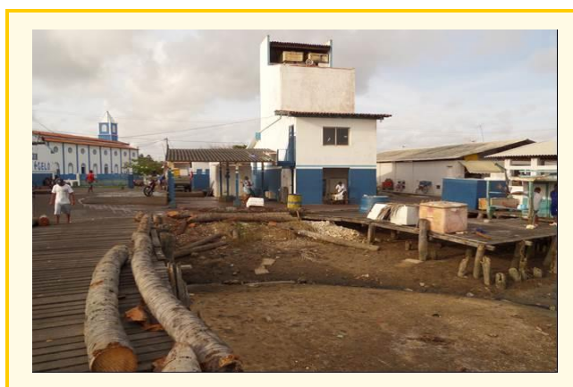
Figura 23 - Infraestrutura de apoio à pesca em Pirambu-SE
