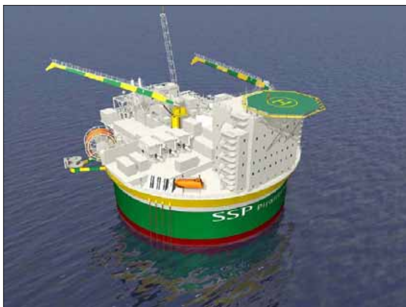
Figura 8.3- 1 - Unidade Marítima SSP Piranema.
