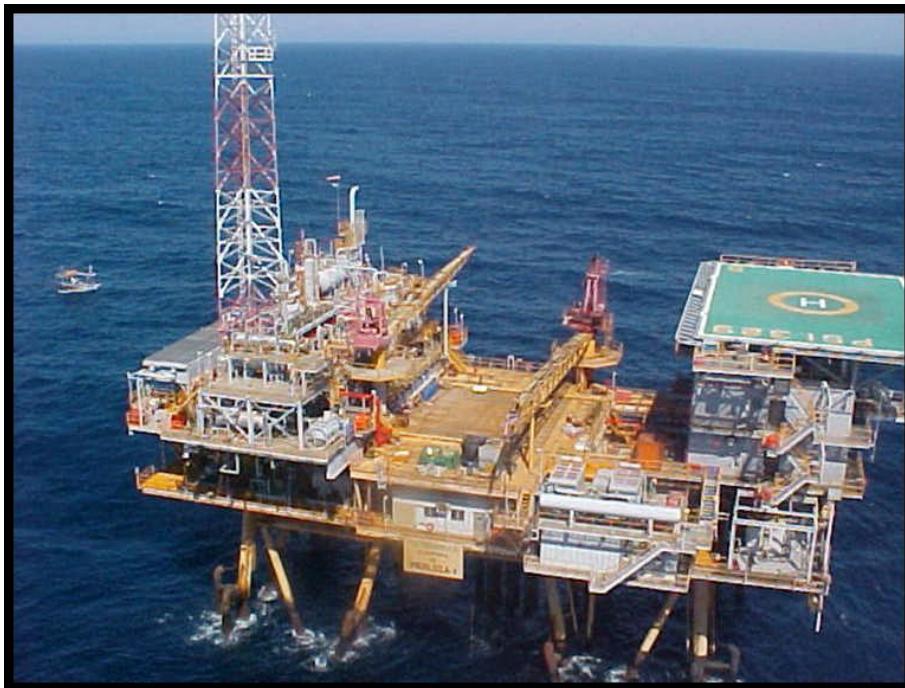
Figura II.8.1- 3: Plataforma PMLZ-1 instalada no Campo de Merluza
