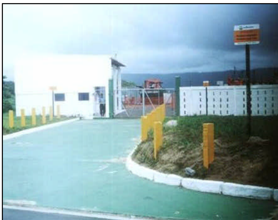
Figura II.5.3-1: Área de chegada do duto de gás no município de Praia Grande (SP) – Vila Mirim. Fonte: Pesquisa Direta, 2004.
