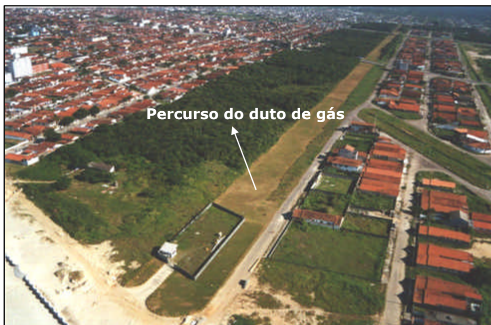
Figura II.5.2-2: Visão aérea do duto de gás enterrado na Praia Grande. Presença de vegetação de restinga à esquerda e condomínio de luxo à direita.
