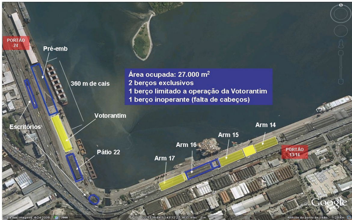
Figura II.2.4.21.2.2.1-1 - Vista aérea do P-RIO
