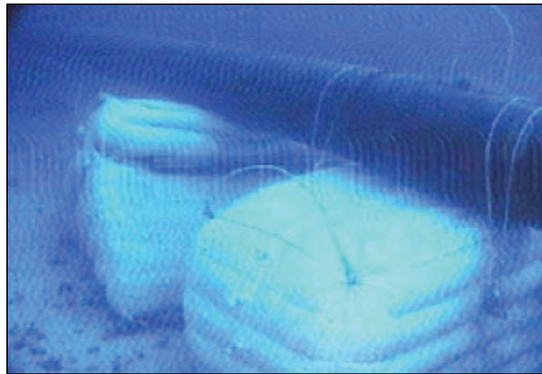
Figura II.2.4.9.4.5-2 - Exemplo de calçamento com "grout bag"
