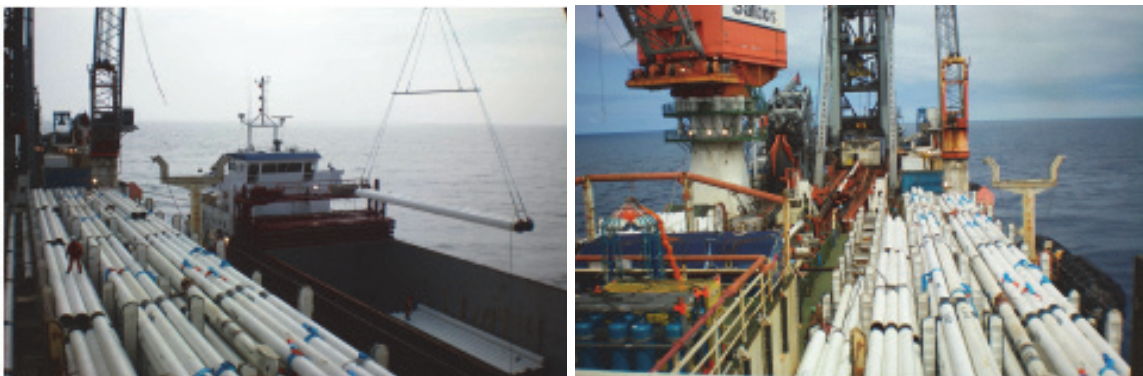
Figura II.2.4.9.4.2-2 - Recebimento dos tubos na embarcação lançadora.
