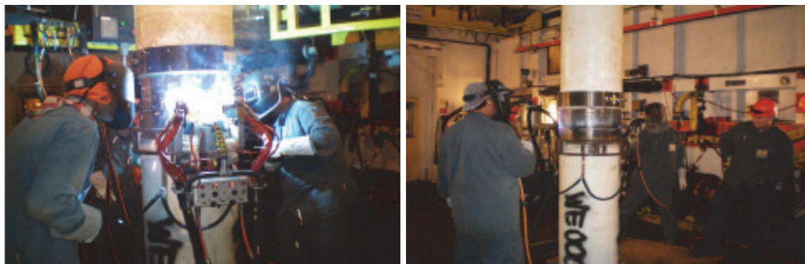
Figura II.2.4.9.4.2-7 - Alinhamento dos Quad Joint.
