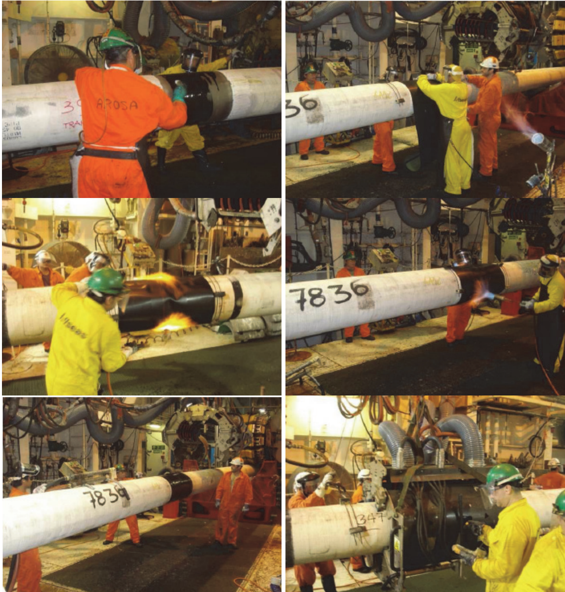
Figura II.2.4.9.4.1-6 - Aplicação do revestimento (aplicação de prime e colocação da manta termoretrátil).
