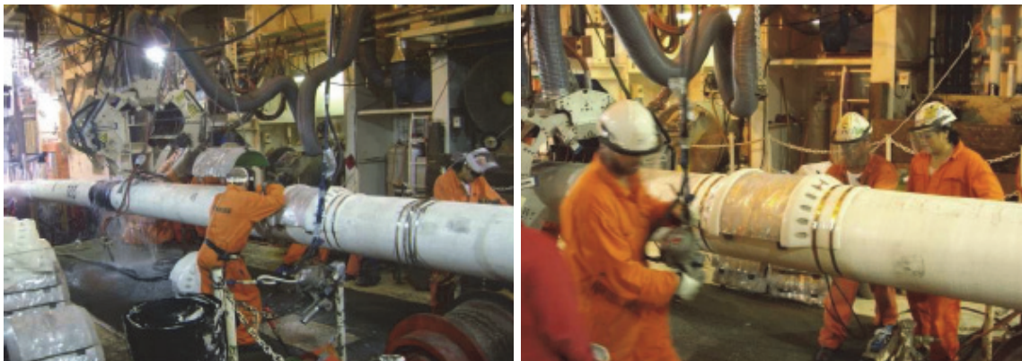
Figura II.2.4.9.4.1-7 - Aplicação dos anodos de sacrifício e do inibidor de propagação de colapso (buckle arrestor).
