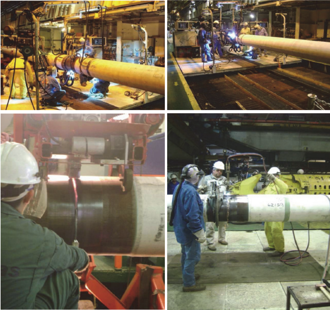
Figura II.2.4.9.4.1-5 - Processo de soldagem automática dos dutos.
