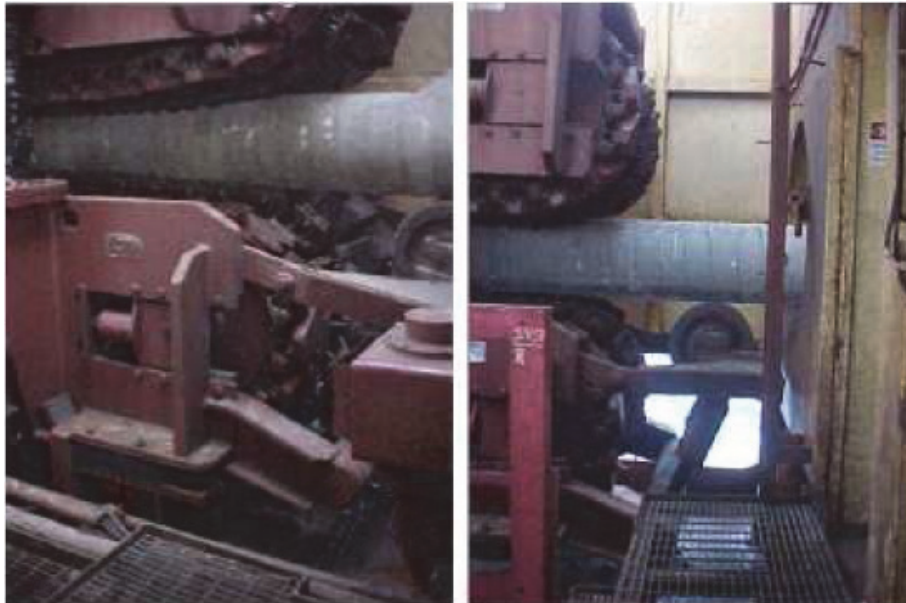
Figura II.2.4.9.4.1-2 - Tracionador de uma embarcação típica de lançamento S-Lay.
