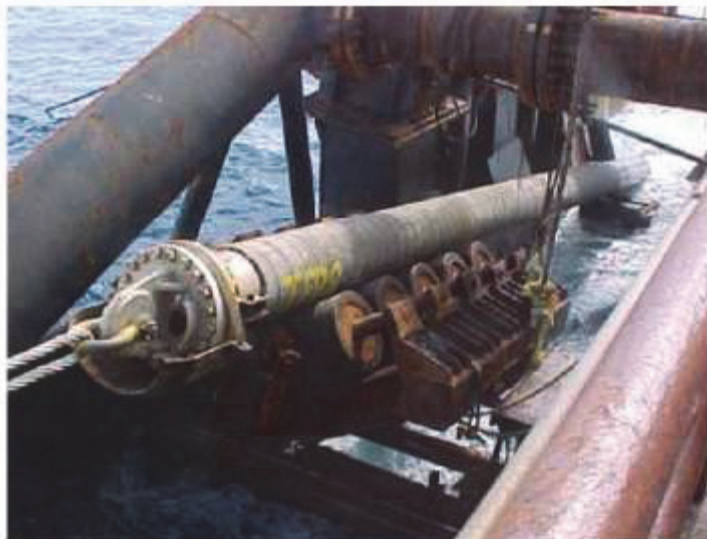
Figura II.2.4.9.4.4-1 - Passagem da cabeça de abandono sobre os roletes da embarcação
