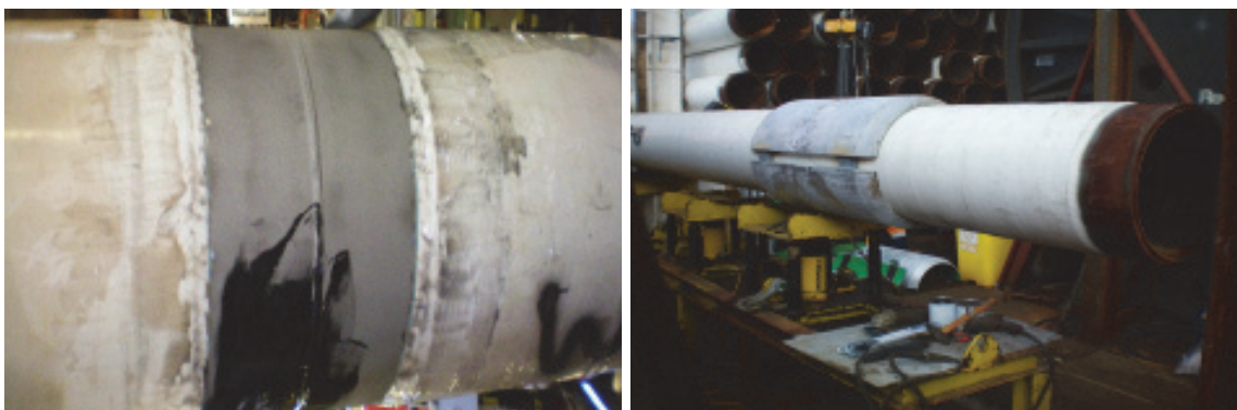
Figura II.2.4.9.4.2-4 - Biselamento dos tubos.
