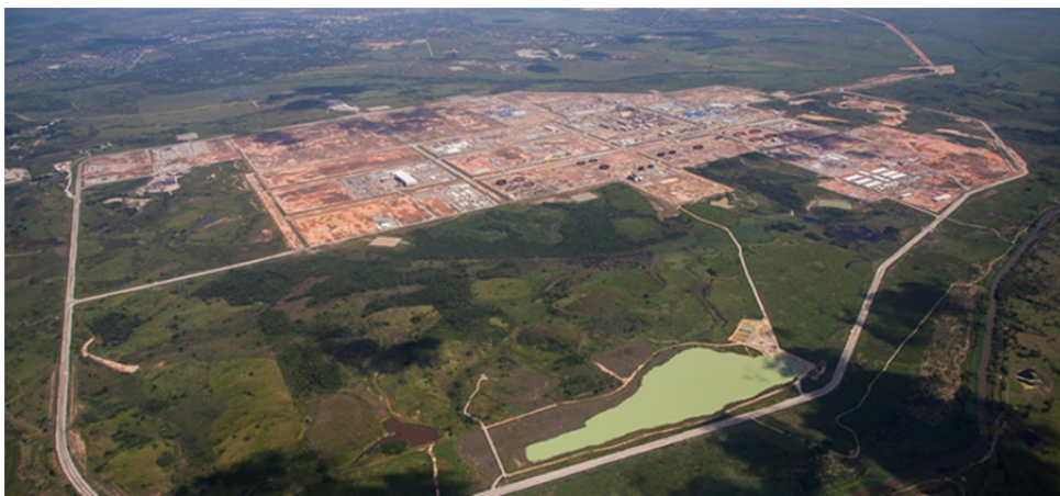
Figura II.5.3.1.8-7 – Vista geral do empreendimento
