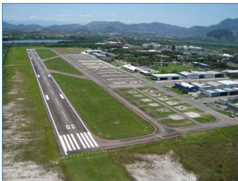
Figura II.2.4-46 - Vista aérea do Aeroporto de Jacarepaguá.
