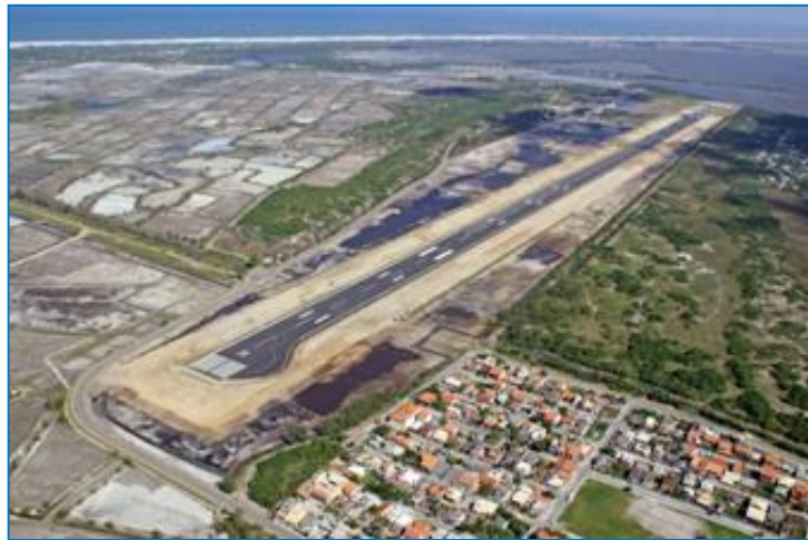
Figura II.2.4-44 - Vista aérea do Aeroporto de Cabo Frio.
