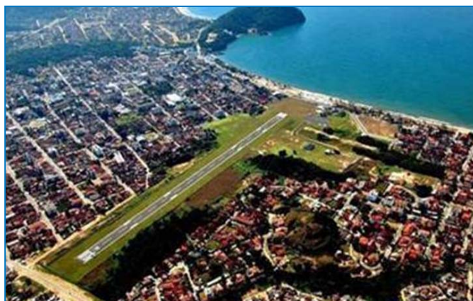
Figura II.2.4-47 - Vista aérea do Aeroporto de Ubatuba.
