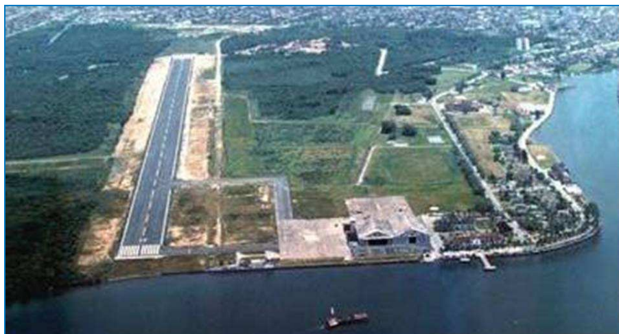
Figura II.2.4-44 - Núcleo da Base Aérea de Santos no Município de Guarujá.
