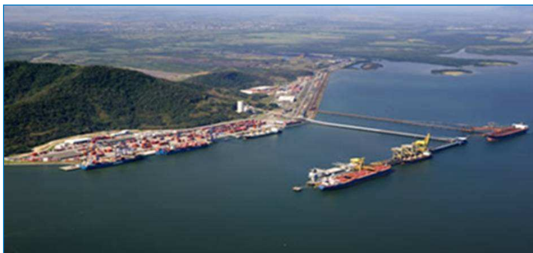
Figura II.2.4-36 - Vista aérea do Porto de Itaguaí.
