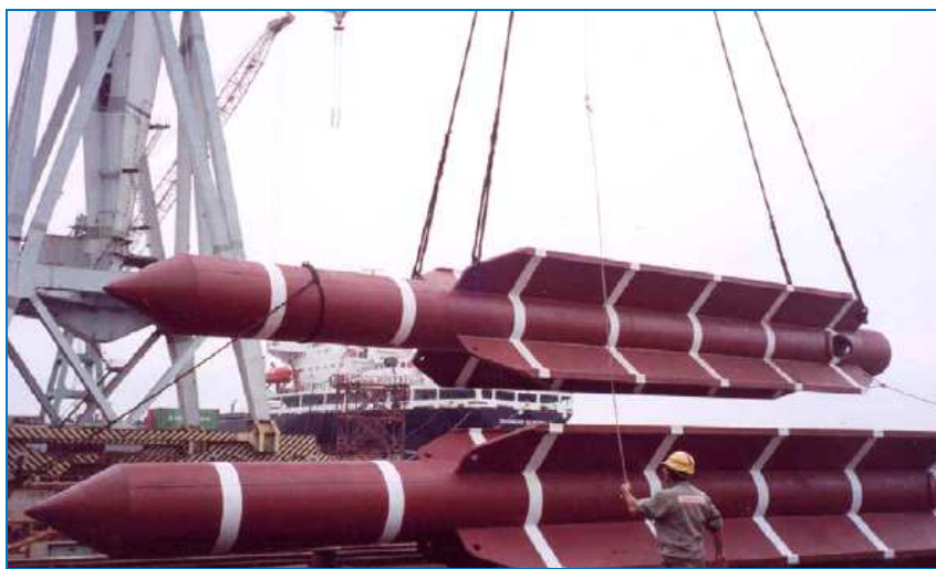
Figura II.2.4-8 - Estaca do tipo torpedo.
