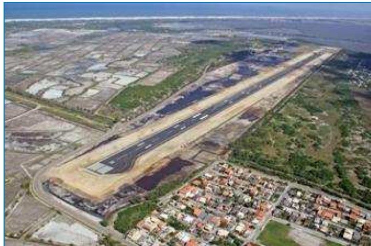
Figura II.2.4-40 - Vista aérea do Aeroporto de Cabo Frio.
