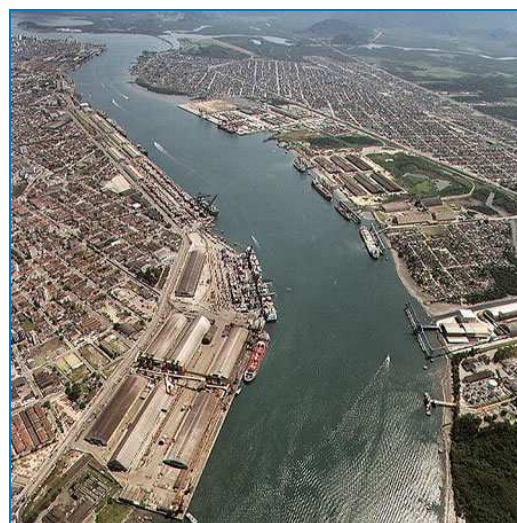
Figura 16 - Vista Aérea do Porto de Santos.
