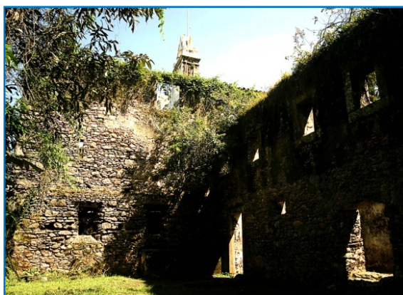
Figura II.5.3-134 - Convento Nossa Senhora da Conceição
