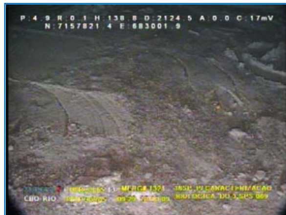
Figura II.5.2-90 - Poço 1-SPS-69 - Centro da locação.
