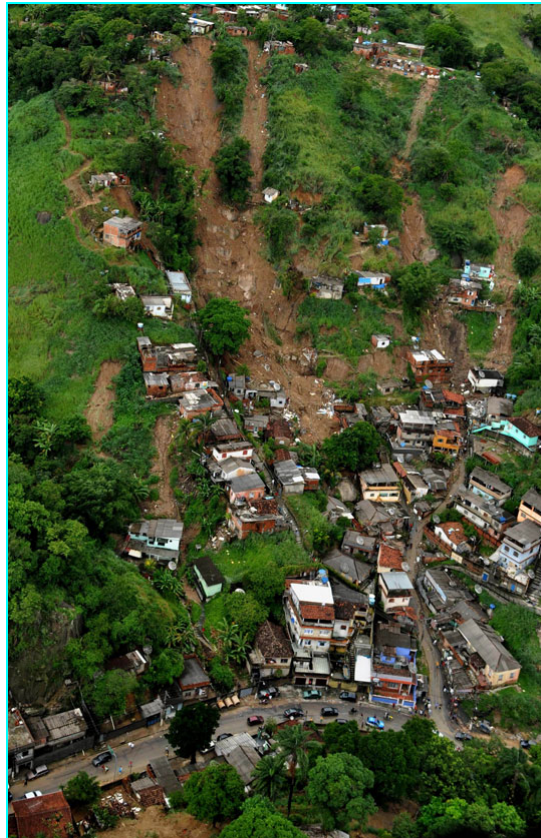
Figura II.5.3.L-5 - Deslizamento no Morro do Bumba – Niterói - RJ.
