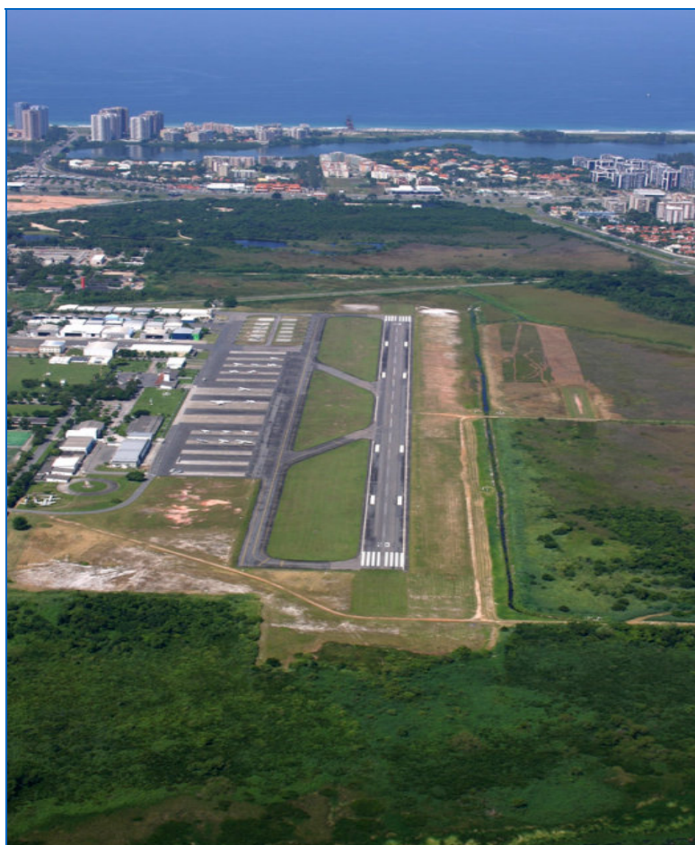
Figura II.2.4-28 - Vista aérea do Aeroporto de Jacarepaguá
