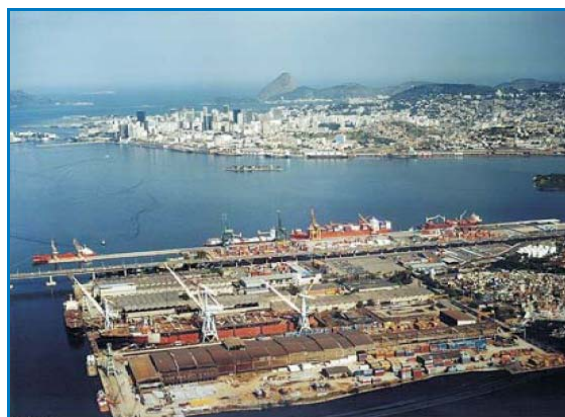
Figura 22 – Vista Aérea do terminal da Bric Brazilian Intermodal Complex S.A.
