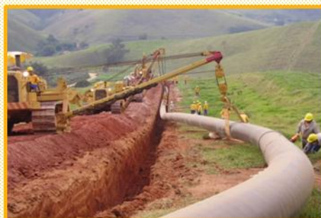
Figura 10. Instalação do Gasoduto Rota 3 no Trecho Terrestre – Passos 3 a 5. Fonte: Petrobras
