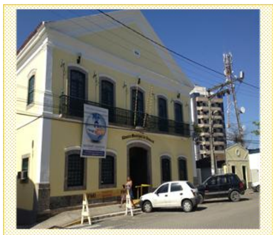
Figura 64. Câmara Municipal de Itaboraí (RJ). Foto: Habtec Mott MacDonald
