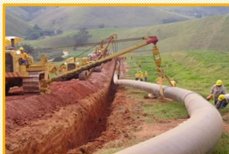
Figura 9. Instalação do Gasoduto Rota 3 no Trecho Terrestre – Passos 3 a 5. Fonte: Petrobras
