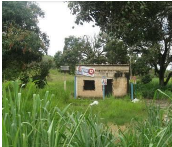
Figura 6.3.2.5-72 - Residência abandonada a 108 metros do Gasoduto (lado direito), em Picos - Itaboraí/RJ.
