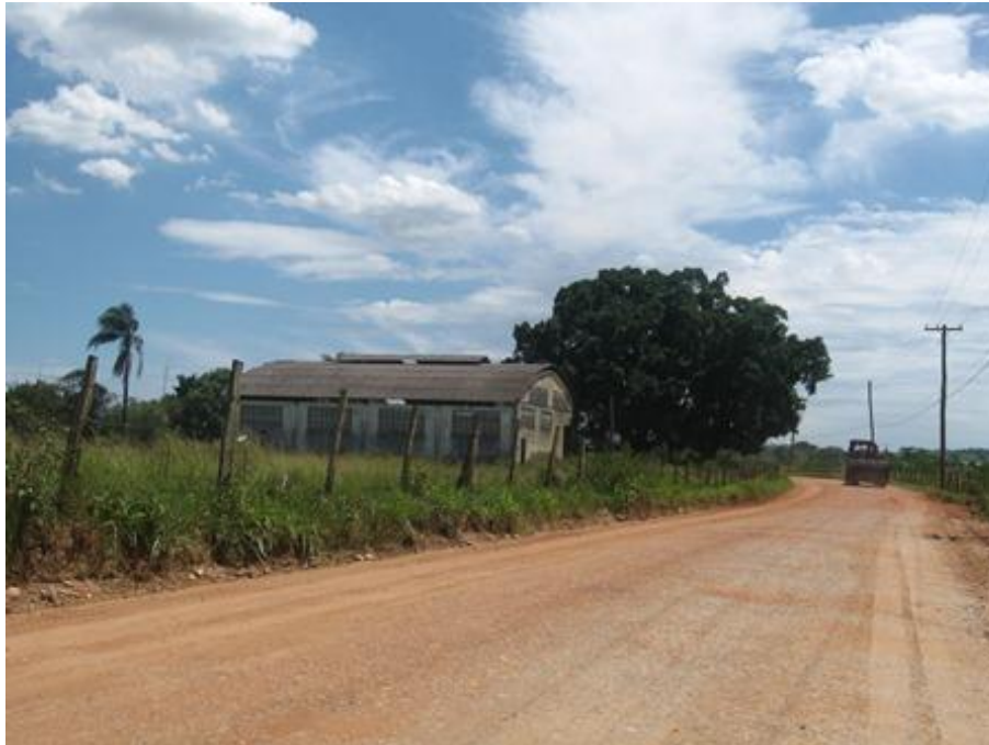
Figura 6.3.2.2-39 - Galpão abandonado em Itapacorá.
