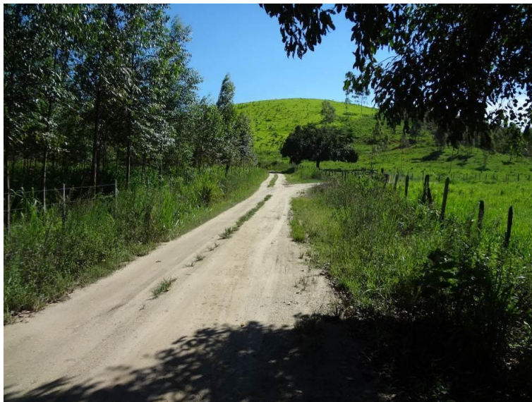
Figura 6.1.4-9 - Travessia de Córrego sem denominação afluente do Rio do Brinquinho, município de Itaboraí (UTM 722.270mE / 7.474.106mN).
