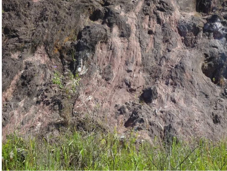
Figura 6.1.5.2-6 - Gnaiss bandado muito alterado do Complexo Paraíba do Sul em talude da RJ-118 (736.721mE / 7.460.450mN). Fonte: Habtec Mott MacDonald, 2012.
