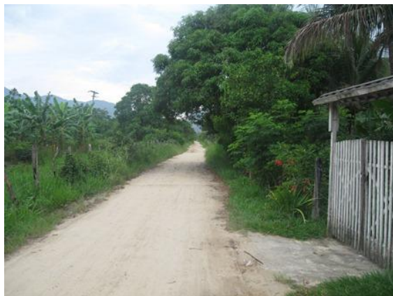
Figura 6.3.2.2-47 - Estrada vicinal Manoel José da Costa sem asfalto, Manoel Ribeiro.
