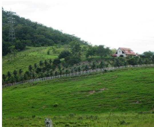
Figura 6.3.2.5-57 - Áreas de pastagem e residência ao longo do traçado, em Itapacorá - Itaboraí/RJ.
