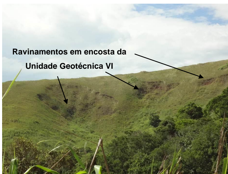
Figura 6.1.5.2-44 - Presença de ravinamentos em encosta da Unidade Geotécnica VI sobre a diretriz do duto UTM 736.476mE / 7.460.669mN).
