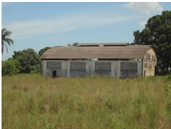
Figura 6.3.2.7-9 - Faixa do duto presença de um galpão abandonado. (ponto 13). Fonte: Habtec.
