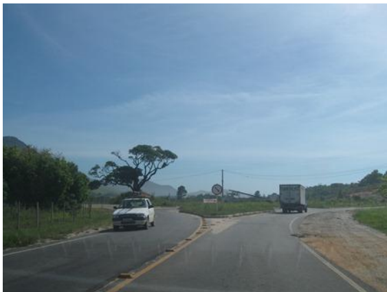
Figura 6.3.2.2-40 - Entroncamento da RJ-118 e RJ-102 (esquerda). Foto: Habtec, 2012.
