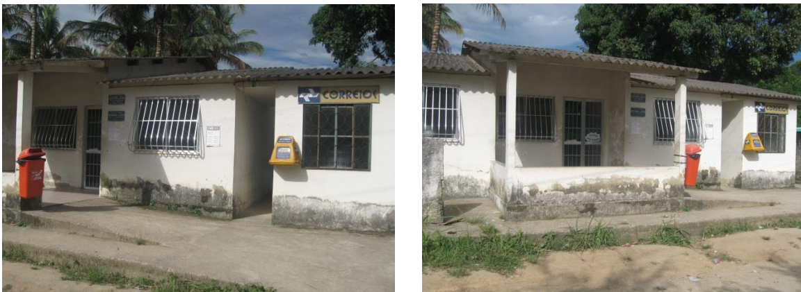
Figura 6.3.2.2-3 - Registro fotográfico do Posto de Saúde de Espirado, situado no município de Maricá. Fonte: Habtec.
