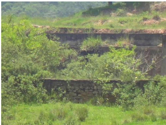
Figura 6.3.2.7-6 - Detalhe de um muro de pedra (Ponto 8). Fonte: Habtec
