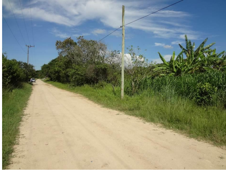
Figura 6.1.5.2-49 - Trecho do duto que corta a Unidade Geotécnica II nas proximidades de loteamento de chácaras no município de Maricá (UTM 734.330mE / 7.462.822mN).
