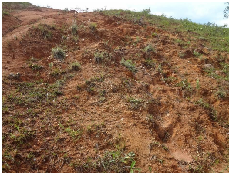
Figura 6.1.5.2-46 - Detalhe de processo erosivo linear em fase inicial (sulco) em solo de alteração a Unidade Geotécnica VI, em encosta próxima a AEL (UTM 734.566mE / 7.461.680mN).
