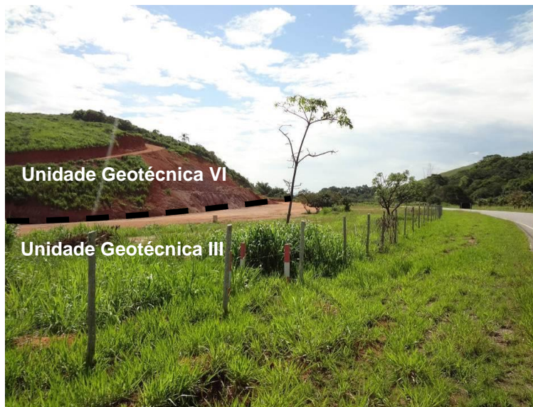
Figura 6.1.5.2-43 - Diretriz do duto próximo a talude sem estabilização com gramíneas nas margens da RJ-118. Limite das Unidades Geotécnicas VI e III (UTM 736.209mE / 7.460.722mN).
