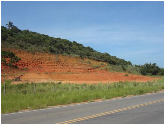
Figura 6.3.2.7-4 - Área antropizada (Sabreira Santa Felicidade) LTDA (Ponto 3). Fonte: Habtec.
