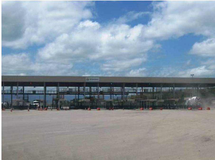
Figura 6.3.2.5-84 - Entrada do COMPERJ, em Sambaetiba - Itaboraí/RJ. Foto: Habtec, Dezembro/2012.
