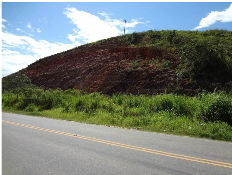
Figura 6.1.5.2-5 - Talude na RJ-118, onde nota-se o perfil de alteração do solo dos gnaisses bandados do Complexo Paraíba do Sul (UTM 737.555mE / 7.461.050mN). Fonte: Habtec Mott MacDonald, 2012.
