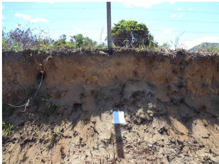
Figura 6.1.5.2-3 - Perfil de alteração do solo dos Sedimentos Marinhos nas proximidades da Estação de Válvula (UTM 739.375mE / 7.461.650mN).
