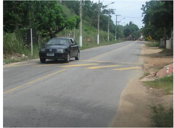
Figura 6.3.2.2-43 - Rodovia RJ-102 - Jacaré.
