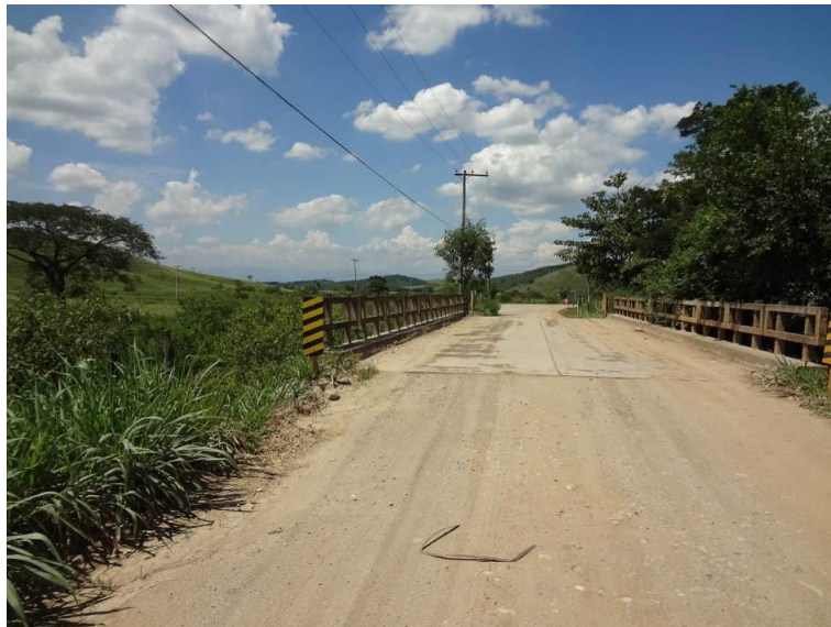
Figura 6.1.4-12 - Ponte nas proximidades da travessia de afluente da margem esquerda do Rio Calundu no município de Itaboraí, citada na figura anterior (UTM 722.537mE / 7.480.182mN).
