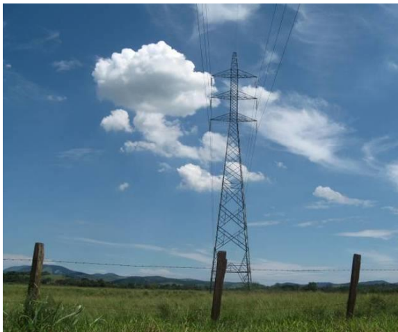
Figura 6.3.2.5-60 - Cruzamento do Gasoduto com LT, em Itapacorá – Itaboraí/RJ. Foto: Habtec, Dezembro/2012.
