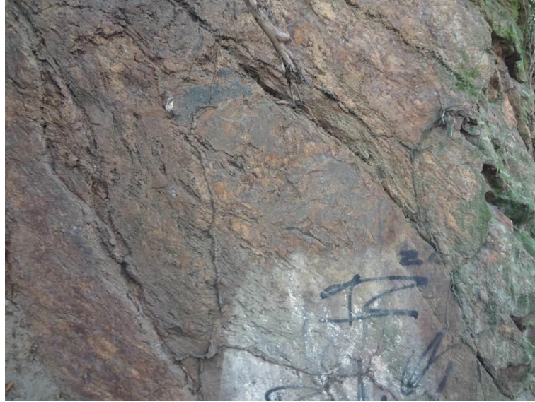
Figura 6.1.5.2-10 - Fraturamento do gnaiss migmatítico alterado e fraturado do Complexo Paraíba do Sul em talude nas margens da RJ-118 (UTM 730.450mE / 7.465.748mN).
