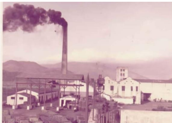
Figura 6.3.2.1-3 - Usina de Tanguá.
