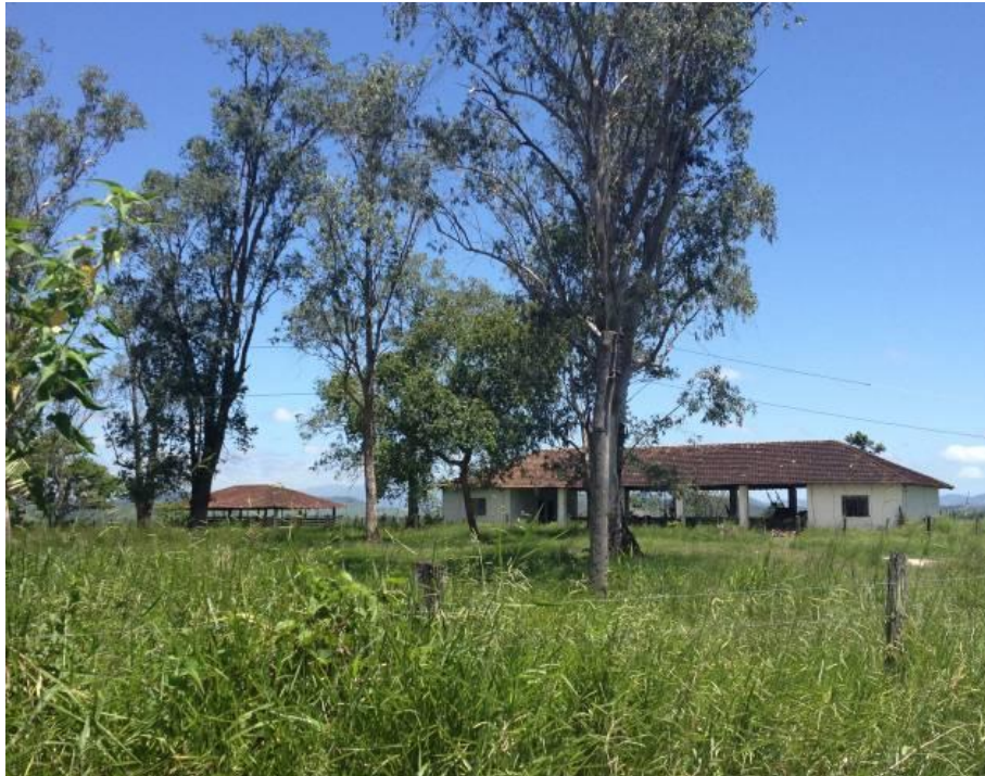
Figura 6.3.2.5-80 - Barracão e Residência a 70 metros do Gasoduto (lado esquerdo), em Sambaetiba - Itaboraí/RJ. Foto: Habtec, Dezembro/2012.
