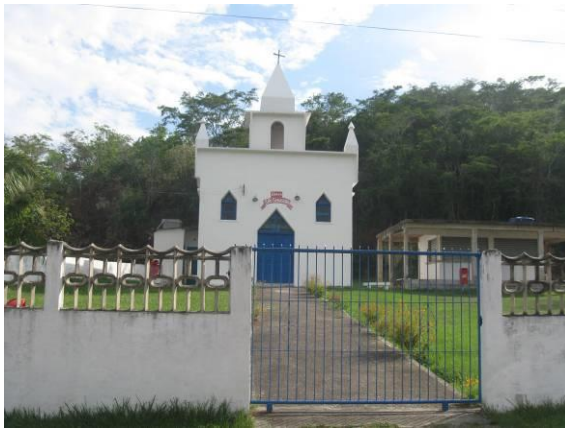
Figura 6.3.2.7-19 - Capela São Sebastião, em Manoel Ribeiro - Maricá/RJ. Fonte: Habtec.
