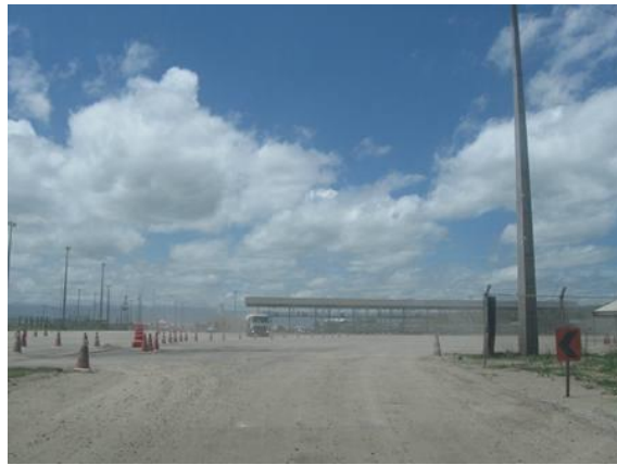
Figura 6.3.2.2-55 - Estrada Comperj de terra compactada.
