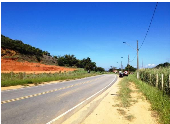
Figura 6.3.2.5-26 - Jazida na RJ-118 em Ponta Negra - Maricá/RJ. Foto: Habtec, Dezembro /2012.
