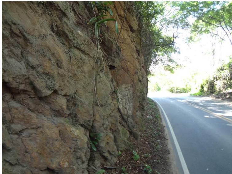
Figura 6.1.5.2-7 - Gnaiss migmatítico alterado e fraturado do Complexo Paraíba do Sul em talude nas margens da RJ-118 (UTM 730.450mE / 7.465.748mN). Fonte: Habtec Mott MacDonald, 2012.
