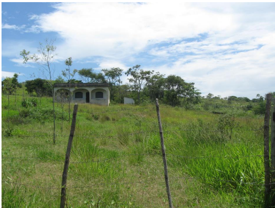
Figura 6.3.2.5-58 - Construção aparentemente abandonada localizada na faixa de servidão do Gasoduto Rota 3. Foto: Habtec, Dezembro/2012.
