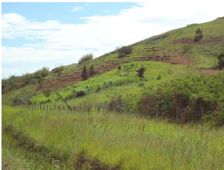
Figura 6.1.5.2-40 - Erosões lineares em encosta da Unidade Geotécnica VI, nas margens da Rodovia RJ-118, dentro da AEL (UTM 737.555mE / 7.461.050mN).
