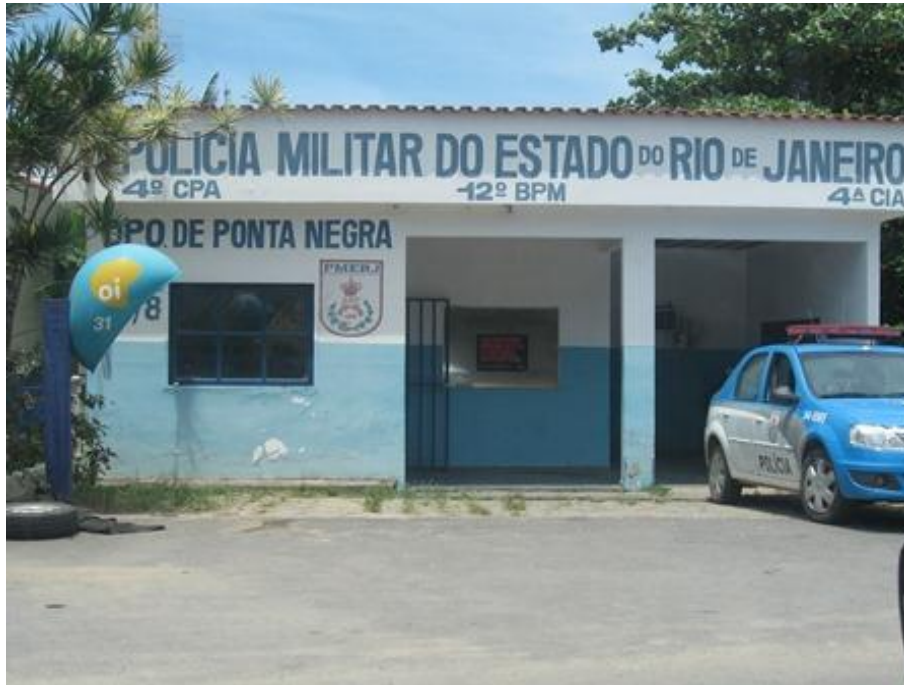
Figura 6.3.2.2-38 - Polícia Militar do Estado do Rio de Janeiro - DPO de Ponta Negra. Fonte: Habtec.
