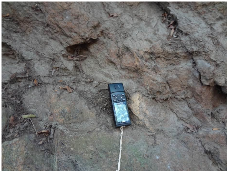
Figura 6.1.5.2-8 - Detalhe do gnaiss migmatítico alterado e fraturado do Complexo Paraíba do Sul em talude nas margens da RJ-118 (UTM 730.450mE / 7.465.748mN).
