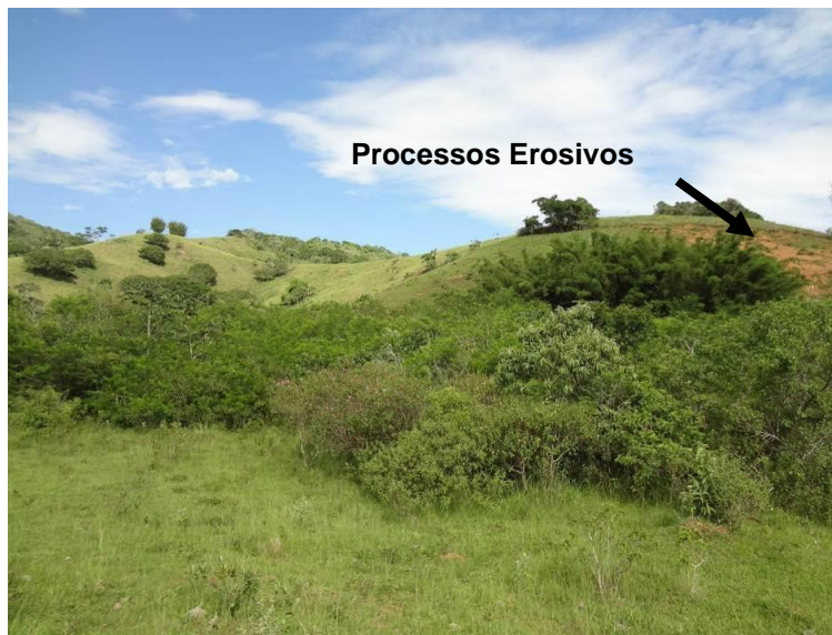
Figura 6.1.5.2-47 - Vista de colinas com topo arredondado referente a Unidade Geotécnica VI, na qual parte de sua encosta apresenta processos erosivos (UTM 734.566mE / 7.461.680mN).
