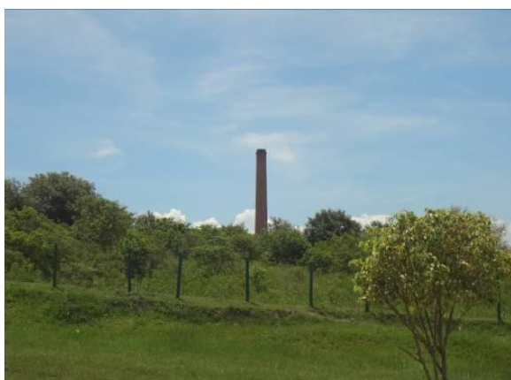
Figura 6.3.2.7-10 - Chaminé da fábrica abandonada. Fonte: Habtec.
