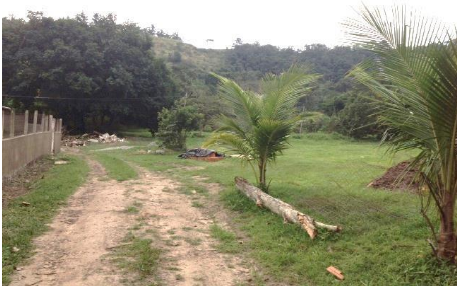
Figura 4.2.6-5 - Detalhe da área onde está prevista a localização do canteiro de obras do furo direcional, abrangendo parte da APASERMAR, em Maricá. Fonte: Petrobras
