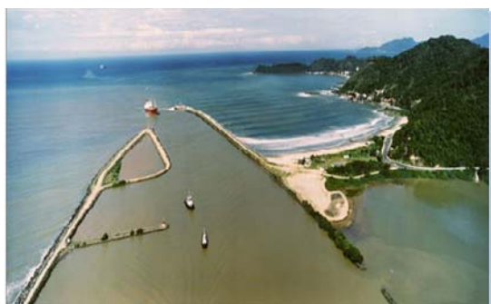
Figura 26 - Canal de acesso ao Porto de Itajaí.
