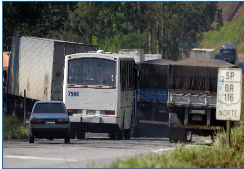
Figura II.5.3.F-5 - Rodovia Régis Bittencourt em trecho sem duplicação
