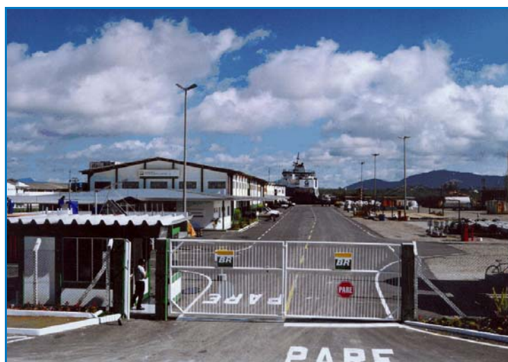
Figura II.2.4-16 - Terminal Portuário da PETROBRAS em Itajaí.
