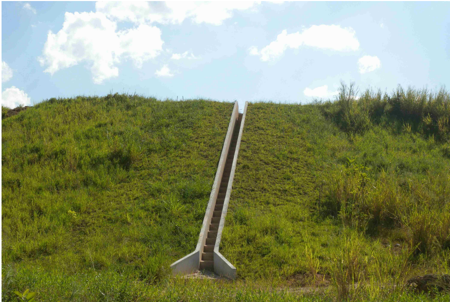
Figura III.2-1 – Implantação drenagem pluvial definitiva e revegetação (GQ).
