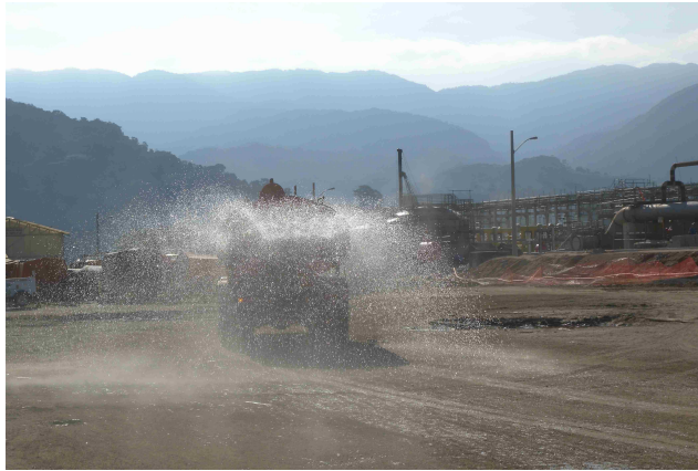
Figura IV.1.1 – Umectação do solo no canteiro de obras.
