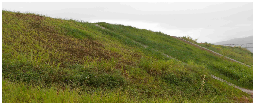
Figura III.2-5 – Construção da base do Flare (GP)
