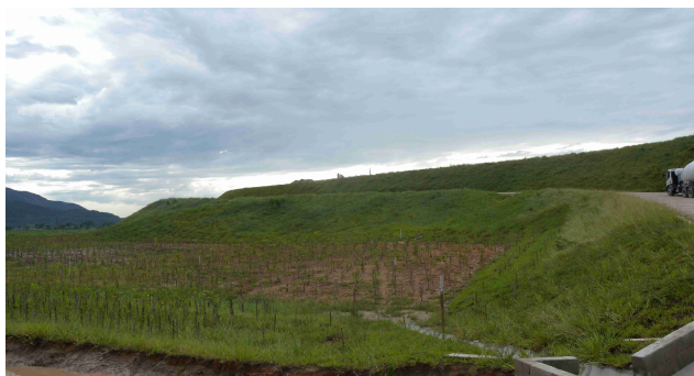
Figura III.2-3 – Implantação drenagem pluvial definitiva e revegetação (GQ)
