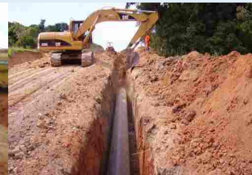
Cobertura da vala
