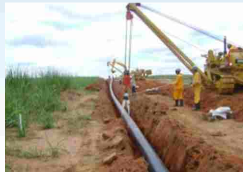
Abaixamento de tubos
