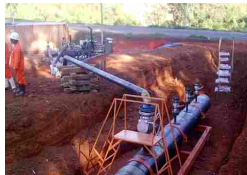
Teste hidrostático
