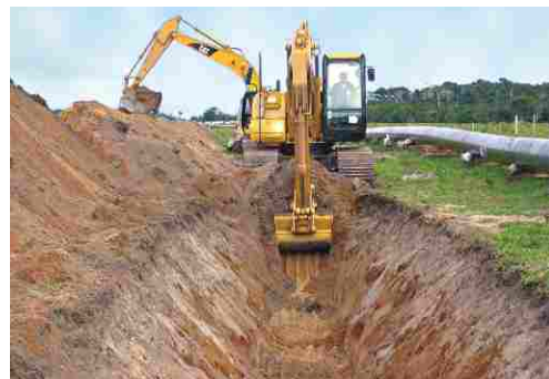
Abertura de vala
