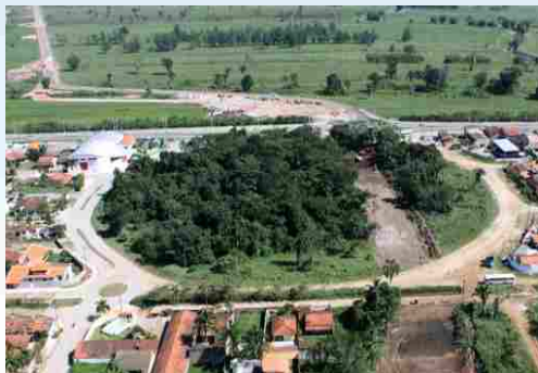
Abertura de pista
