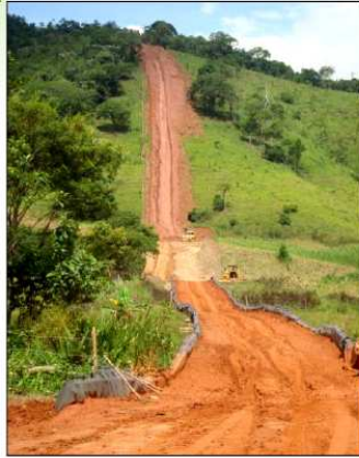
Abertura de pista
