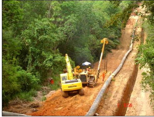
Abertura de vala
