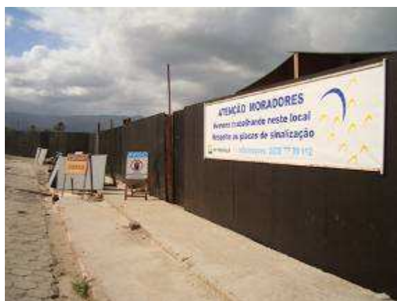
Figura V.3-3 – Sinalização no canteiro da Praia das Palmeiras, em 09/04/10.
