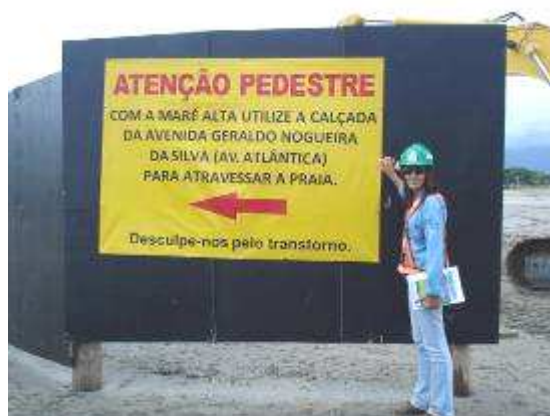
Figura V.3-4 – Faixa no canteiro da Praia das Palmeiras, 03/04/10.
