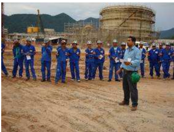
Figura IV.2-9 – DDSMS sobre “Campanha das Mãos”, na área do K7, em 07/01/2010.
