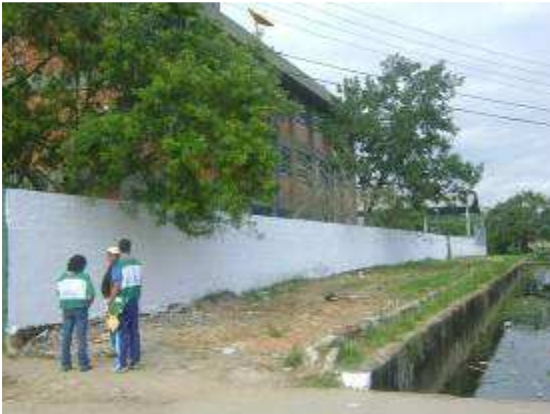
Figura V.2.1-65 – Gincana da EE Antônio Bernardino: muro, ao lado do rio da Paca, antes da pintura.
