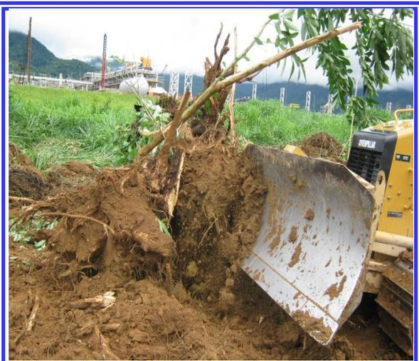
**Foto II.1-2 –** Retirada de árvores isoladas.
