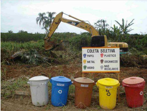
Figura IV-1 Implantado a coleta seletiva nas frentes de serviço.
