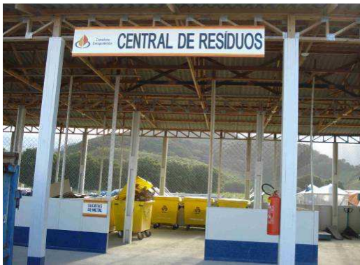
Figura IV-3 Canteiro de apoio – Central de Resíduos.
