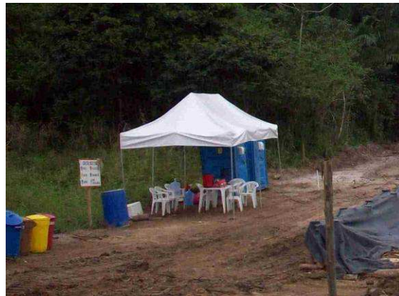
Figura IV-2 Frente de serviço - Área de vivência com sanitários químicos.
