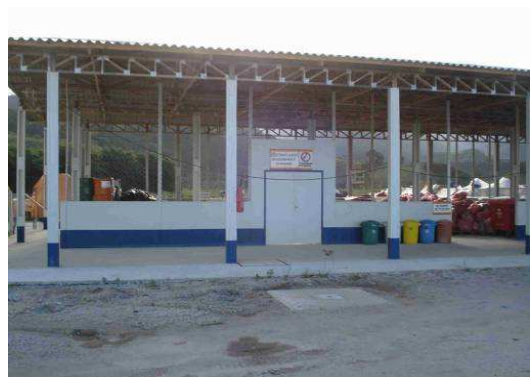
Figura IV-4 Canteiro de apoio – Central de Resíduos
