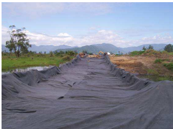
Figura III.2-16 Área 04: Estiva completamente coberta com manta geotêxtil.
