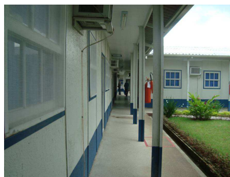
Figura III.2-6 Canteiro de apoio – área administrativa interna.
