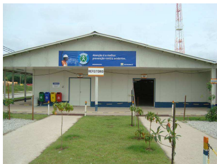
Figura III.2-3 Canteiro de apoio – área do refeitório.
