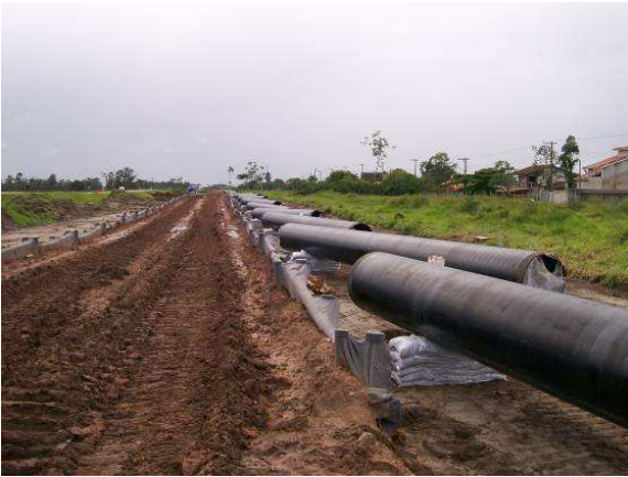
Figura III.2-22 Tubulação desfilada ao longo da faixa de dutos.
