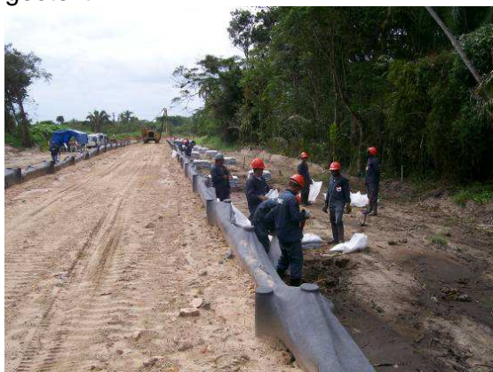
Figura III.2-18 Preparação de sacaria para receber tubulação.
