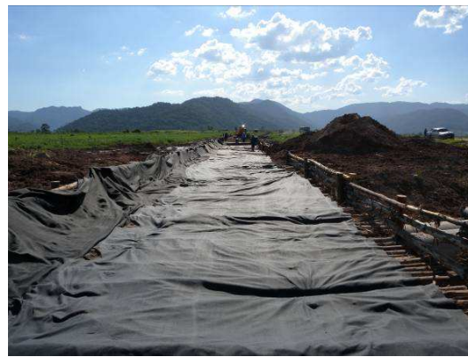
Figura III-2-24 Estiva pronta para a colocação da manta geotextil (N7382998 E 450500).
