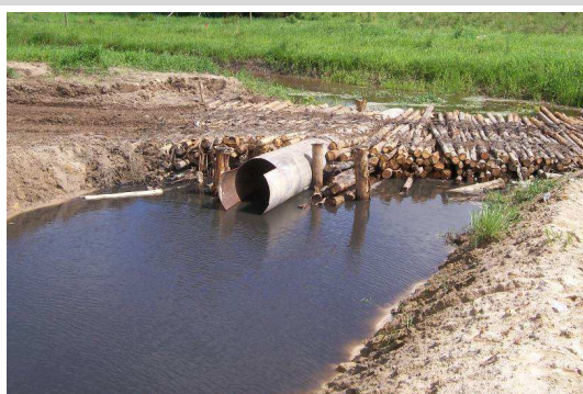
Figura III.2-10 Montagem de estiva colocação de tubulação para não impedir a
