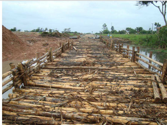
Figura III.2-15 Área 04: Estiva pronta para a colocação da manta geotextil.
