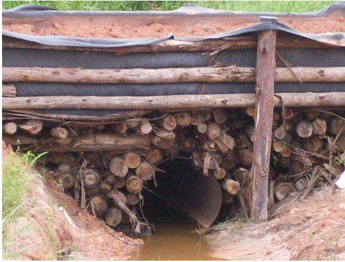
Figura III.2-11 Na construção de estiva - tubulação colocada para permitir a drenagem da área.
