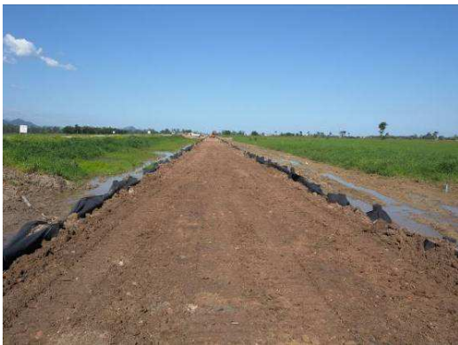
Figura III-2-25 Área 04: Estiva completamente coberta com manta geotextil (N7382998 E 450500).
