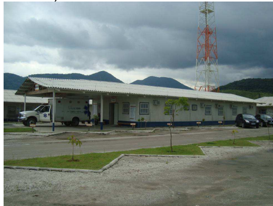
Figura III-2-26 Vista do ambulatório do canteiro de apoio a obra ( N7383890 E448544).
