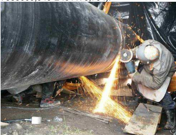
Figura III.5-3 Atividade de acabamento de tubulação (N 7383009,949 E451175,794).
