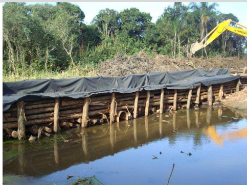
Figura III.2-9 Montagem de estiva colocação de tubulação para não impedir a
