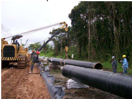
Figura III.2-20 Tubulação desfilada sobre sacaria na faixa de dutos.
