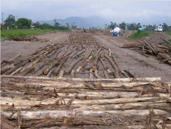
Figura III.2-14 Construção da Estiva na área 04: Colocação das Toras Longitudinais e Transversais.
