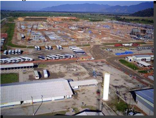
Figura III.2-13 Vista do canteiro de apoio utilizado para a construção e montagem do gasoduto trecho terrestre.
