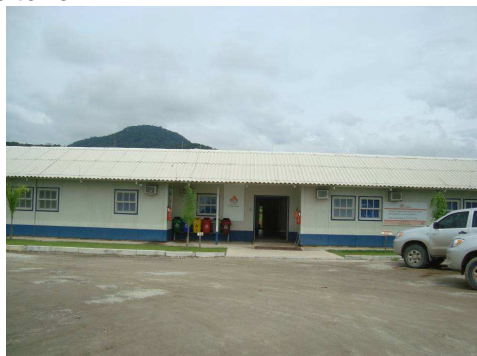
Figura III.2-5 Canteiro de apoio – área administrativa.
