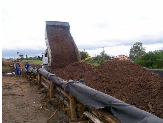
Figura III.2-17 Área 04: Descarregamento de solo na Estiva.
