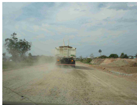
Figura III.2-8 Caminhão pipa umectando estrada de acesso lindeira a faixa de duto.
