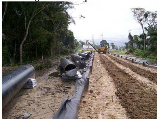
Figura III.2-21 Tubulação desfilada na faixa de dutos.
