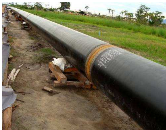
Figura III.5-4 Tubulação soldada (N7383151 E453447,527).
