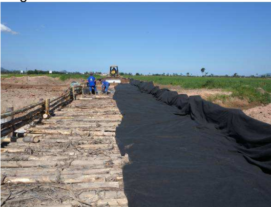
Figura III.2-23 Construção da Estiva: Colocação das Toras Longitudinais e Transversais (N7382998 E 450500).
