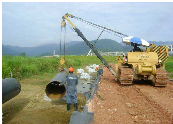
Figura III.2-19 Trator Side Boom descarregando tubulação.
