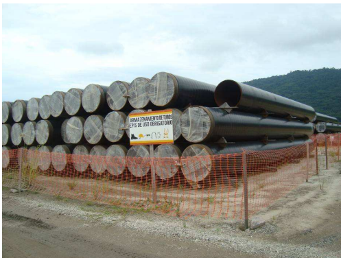
Figura III.2-7 Canteiro de apoio – armazenamento de tubulação.
