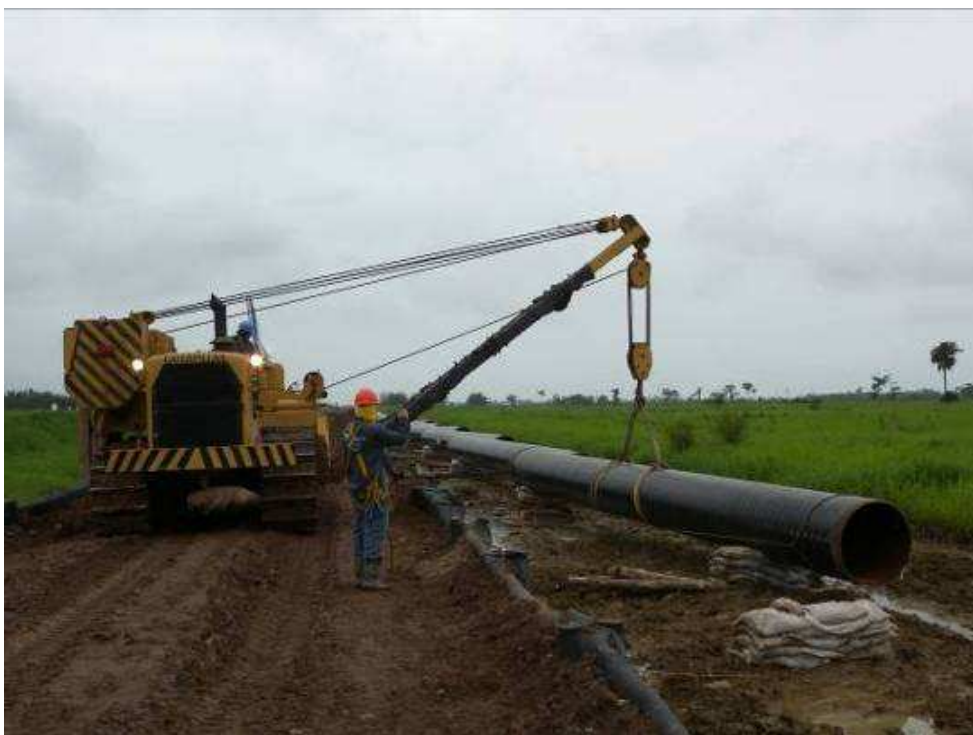
Figura III.4-4 Desfile de tubulação na faixa de dutos sobre a sacaria (N7382998 E 450500).
