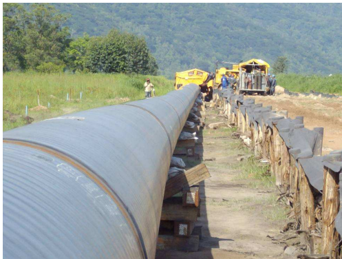
Figura III.5-1 Vista da tubulação soldada com a fase de solda ao fundo (N 7383009,949 E451175,794).
