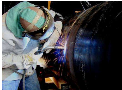
Figura III.5-2 Soldagem da tubulação (N 7383009,949 E451175,794).
