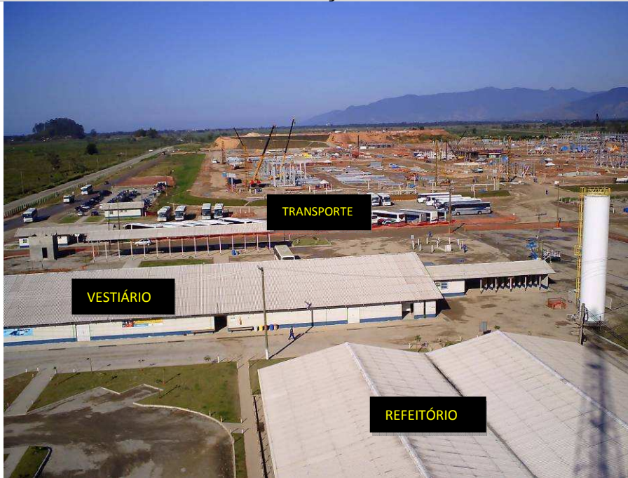
Figura III.2-1 Vista aérea do canteiro de obras– Identificação dos centros de apoio (Imagem com finalidade ilustrativa).
