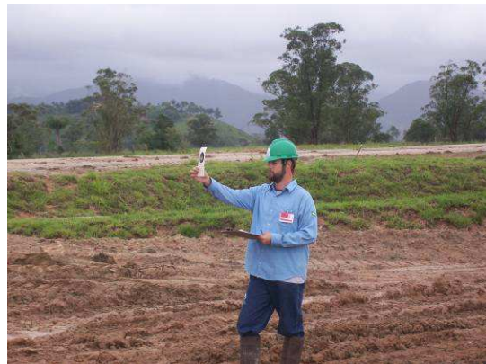
Figura IV-4-2 Aferição pela Escala Ringelmann em todas as máquinas e equipamentos da frente de serviço do gasoduto.
