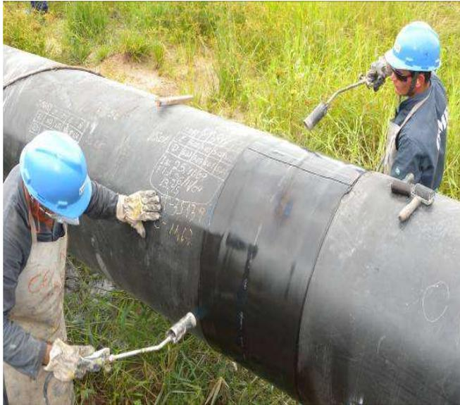
**Figura III. 4-1** Soldagem concluída segue aplicação de revestimentos.
