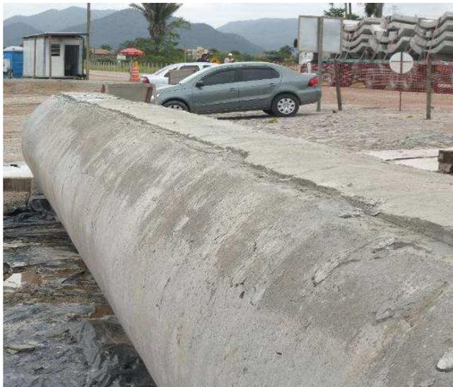
**Figura III. 5-1** Soldagem concluída segue aplicações de revestimentos.
