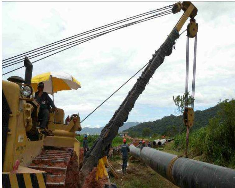
**Figura III. 3-1** Trator *Side Boom* deslocando a tubulação para a faixa de dutos
