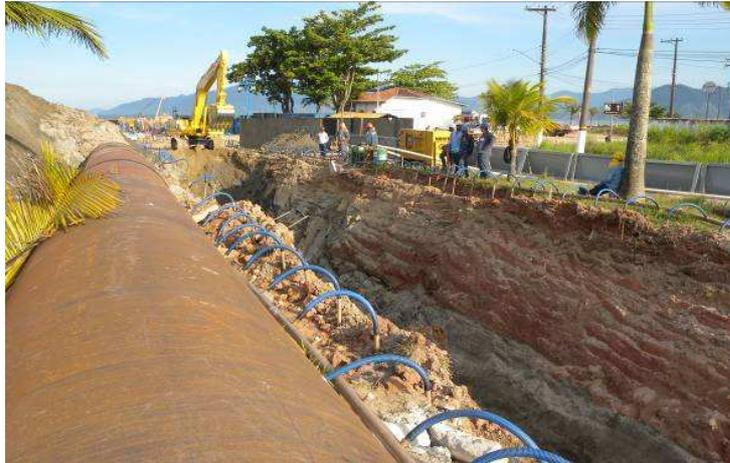
**Figura III. 6-3** Abertura de Vala com Abaixamento de Tubulação
