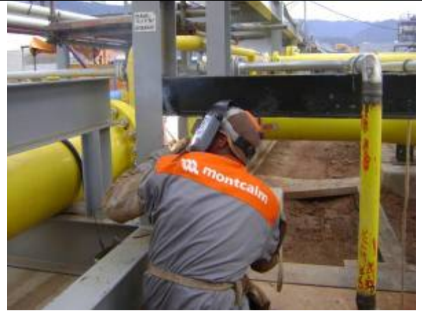
Montagem de Tubulação
