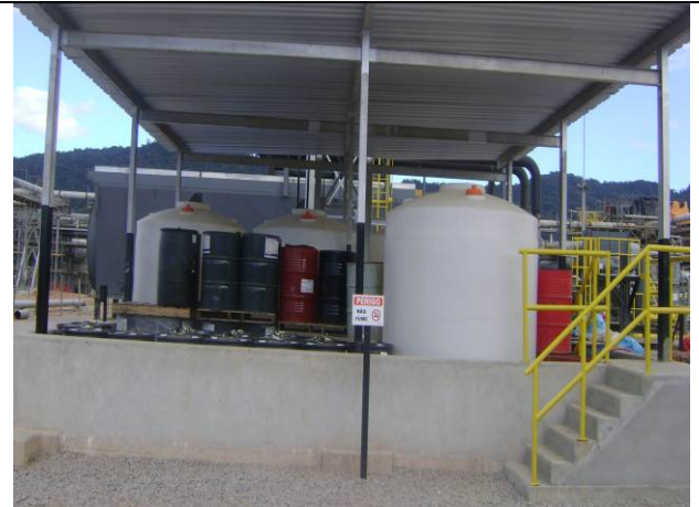
Área para Armazenamento de Produtos Químicos
