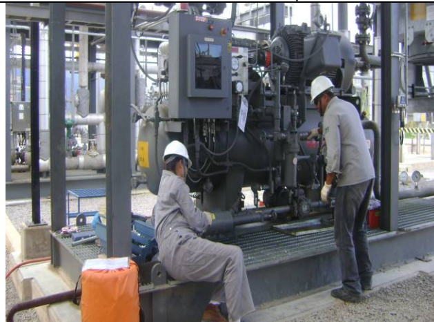
Comissionamento Compressor de Propano
