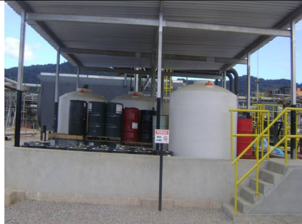
Área para Armazenamento de Produtos Químicos
