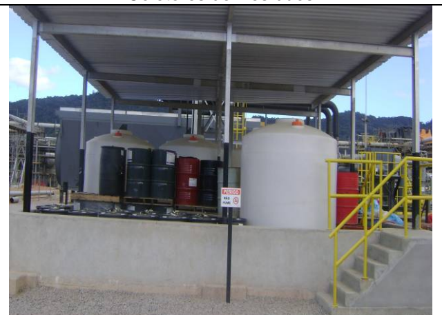
Área para Armazenamento de Produtos Químicos
