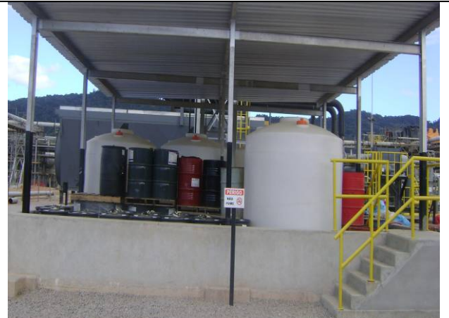
Área para Armazenamento de Produtos Químicos
