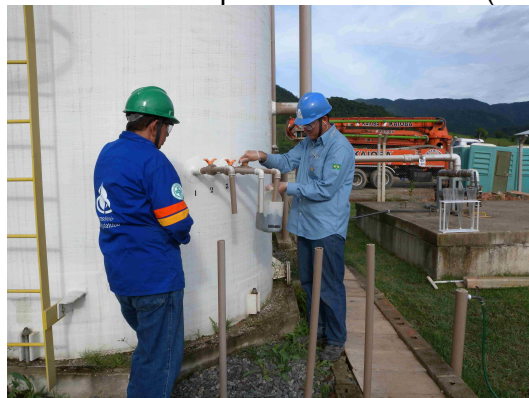
Figura III.6 Execução de melhorias operacionais na ETE (EK).
