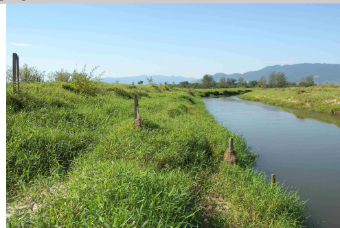
Figura III.19 Conjunto de réguas linimétricas junto ao Rio Camburu.
