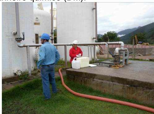
Figura III.20 Monitoramento de Efluentes – ETE (EK).
