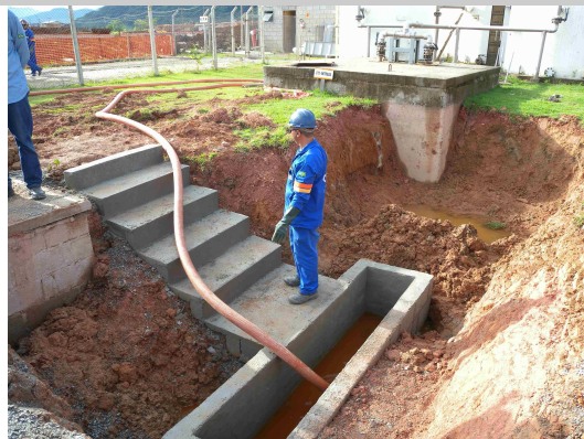
Figura III.4 Execução de melhorias operacionais na ETE (EK).
