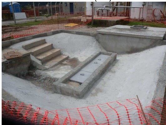
Figura III.11 Execução de melhorias operacionais na ETE (EK).
