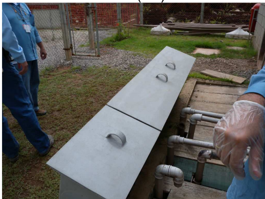
Figura III.10 Execução de melhorias operacionais na ETE (EK).
