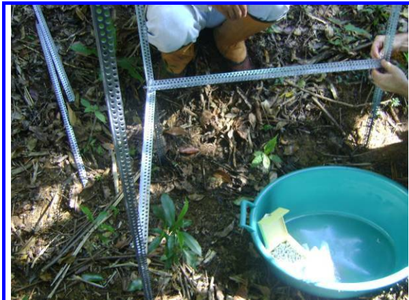
Foto II.2.2-4 – Montagem das bases da estrutura de biomonitoramento no P1. (Coordenadas: 456669 E; 7389677 N)
