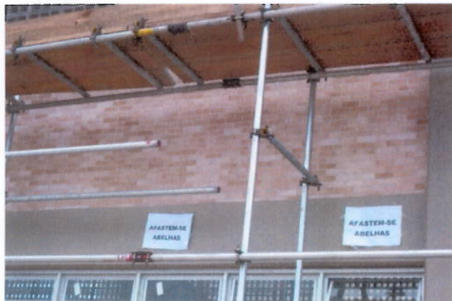
Foto 01 - Sinalização da área.
