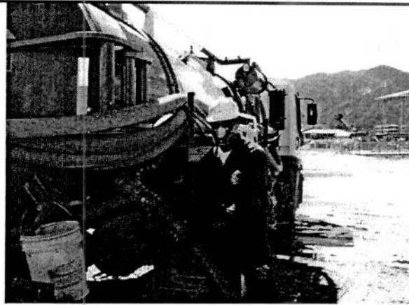
Foto 02 – iniciação da mitigação – encaixe do mangote.
