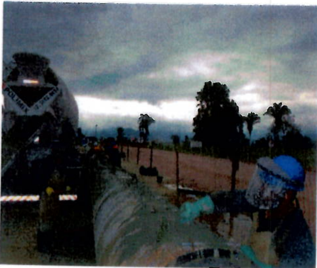
Foto 03 - Tubulação recebendo o concreto
