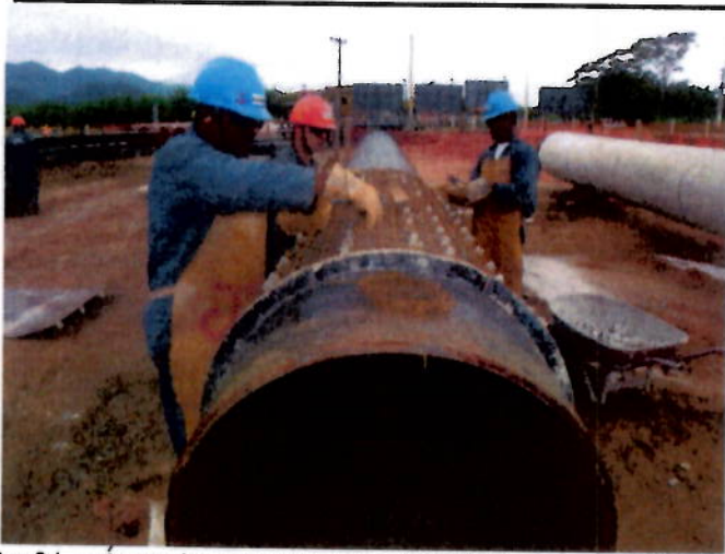
Foto 01 - Área de concretagem de tubos, preparação para receber o concreto.
