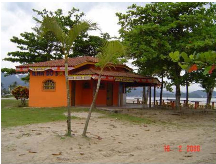
Figura 6.2.3-3 - Quiosque padrão da Praia de Indaiá, situado próximo ao local de implantação do duto.
